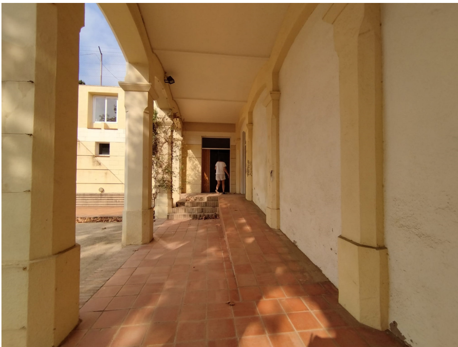
Porxo i entrada nova Sala de cerimònies.
