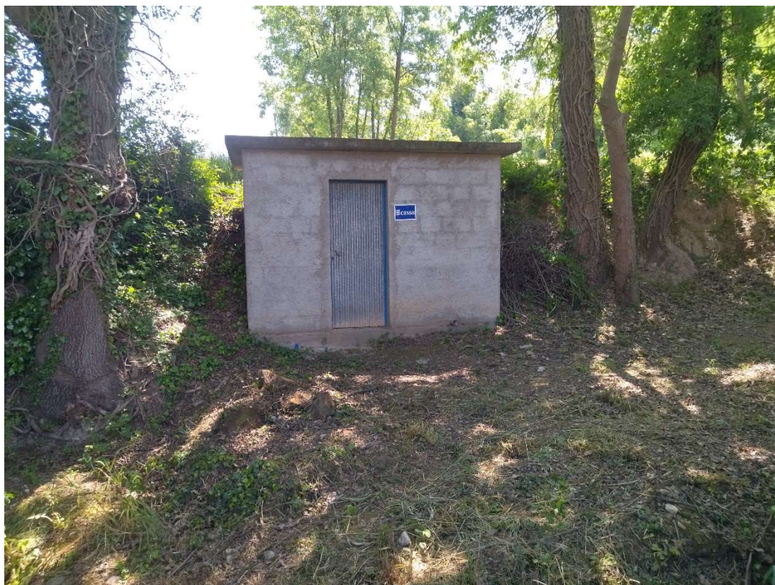
CASETA PUNT FINAL
