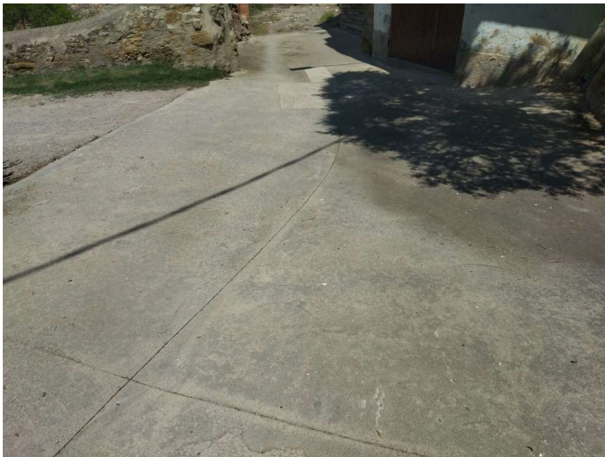
PRIMER TRAM EN PAVIMENT DE FORMIGÓ
