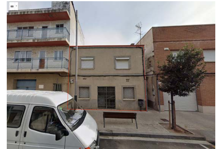
EDIFICI A ENDERROCAR
