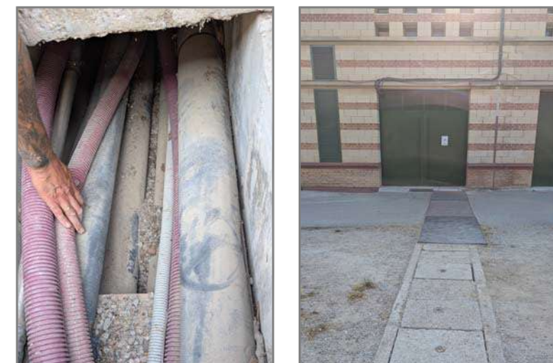
FOTOGRAFIA 3-4. CANALITZACIÓ DE FORMIGÓ
