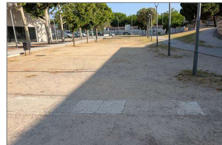
FOTOGRAFIA 2. ZONA RASA SOTERRADA I CANALITZACIÓ DE FORMIGÓ
