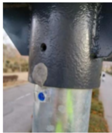
Figura 4. Precintado soporte exterior
