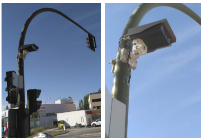
Instalación en carretera
