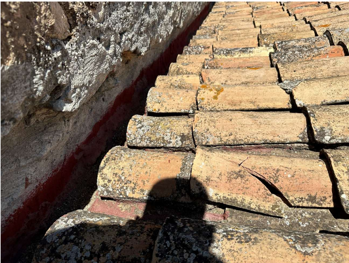
Detall canal coberta inclinada
