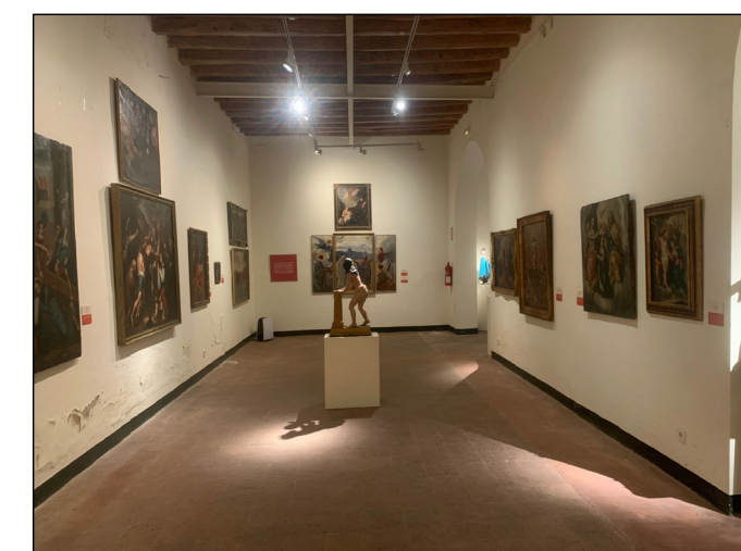
9. Instal·lació d'un sistema contra les humitats per capil·laritat basat en l'electroosmosi 13. Repintat dels paraments verticals afectats per humitats
