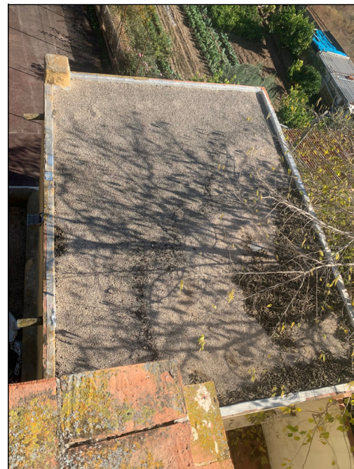
2. Aixecament coberta i formació nova coberta plana
