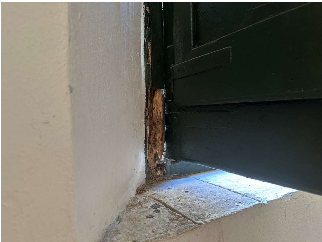
Detall fusteria exterior de la façana principal
