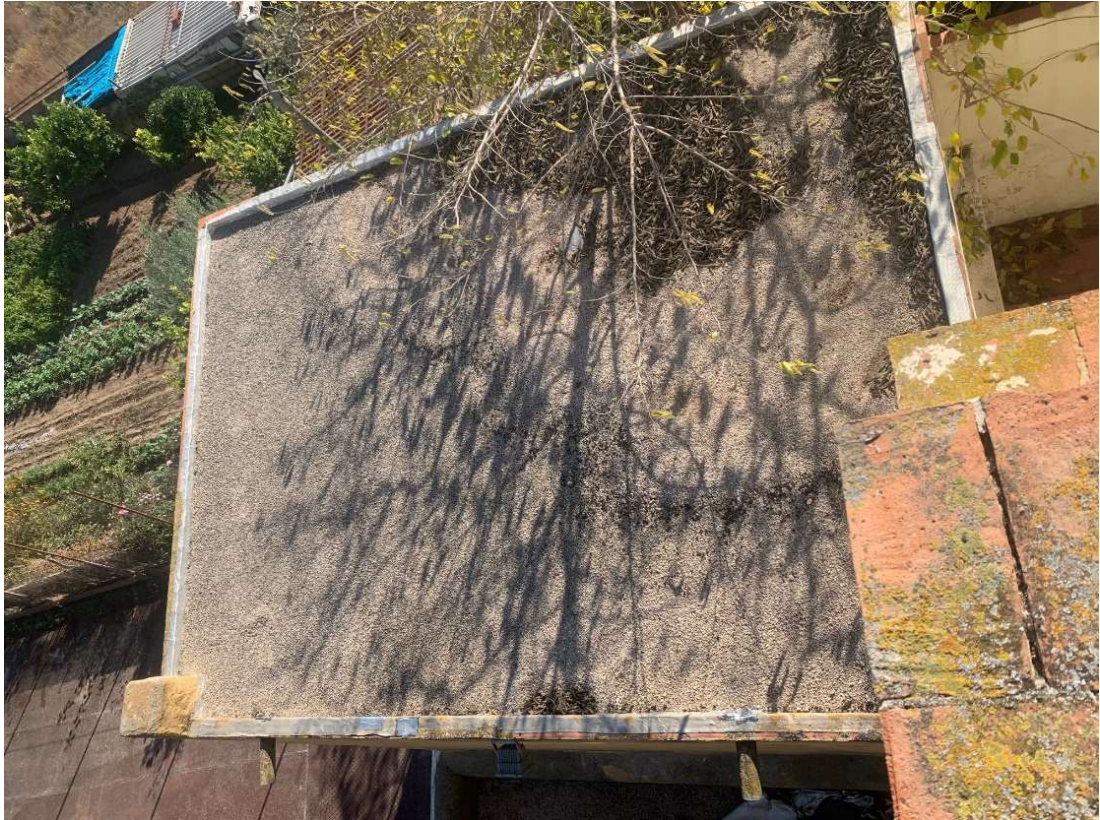
Coberta plana no transitable Sala 10 (Paleontològica)Terrat
