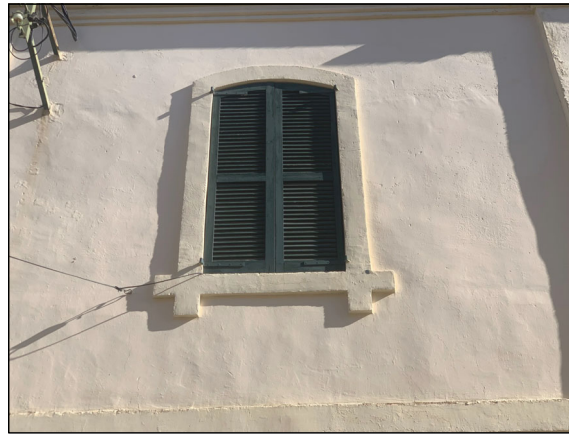
7. Treballs pintura en fusteria o persianes exteriors de fusta
