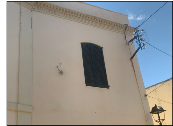
7. Treballs pintura en fusteria o persianes exteriors de fusta
