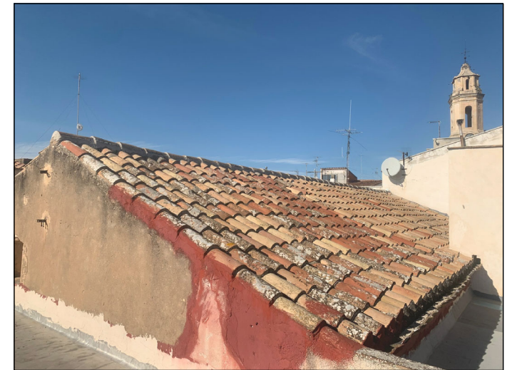
1. Substitució teules trencades
