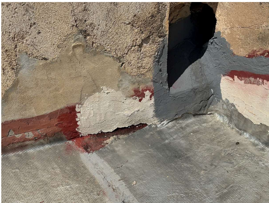
Detall impermeabilització terrat
