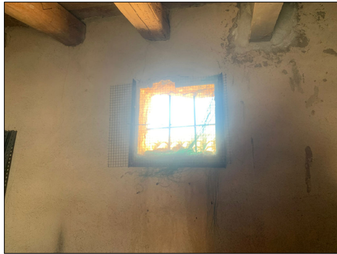
5. Instal·lació de noves finestres de fusta massissa i doble vidre
