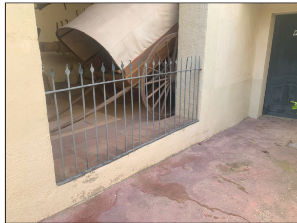
8. Treballs pintura en baranes i reixes exteriors metàl·liques
