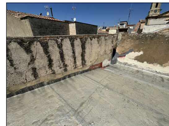
3. Aixecament coberta i formació nova coberta plana
