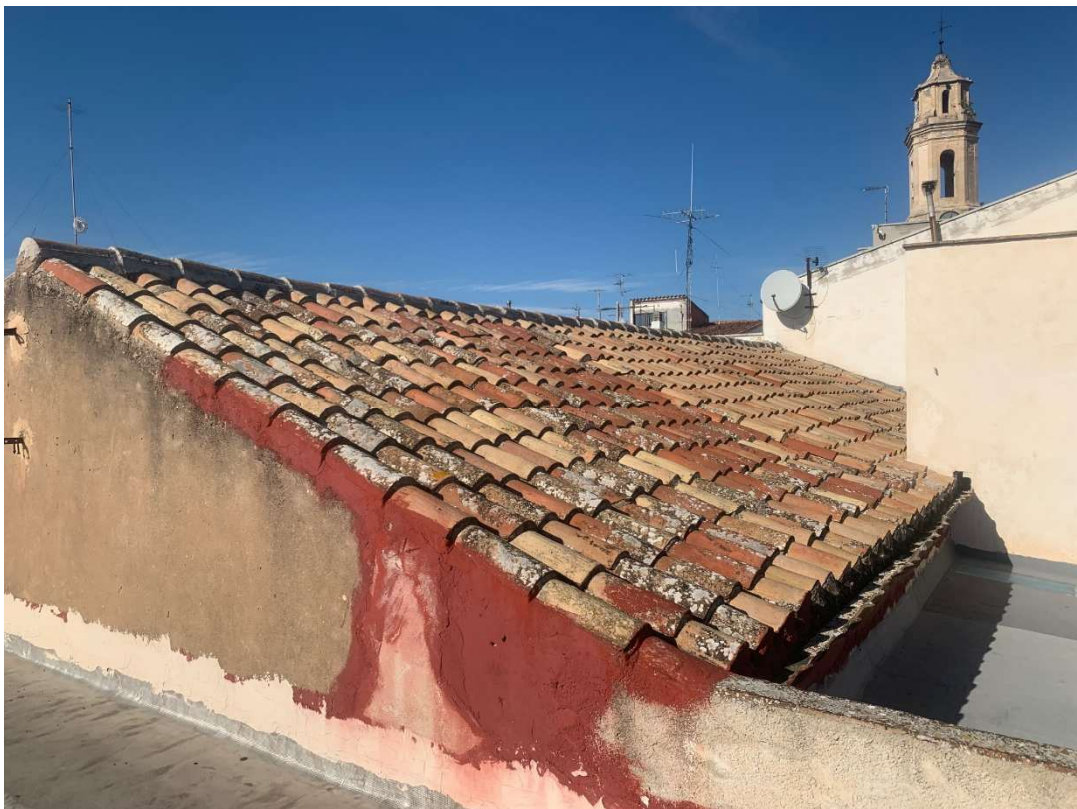
Trobada coberta inclinada i terrats 1 i 2
