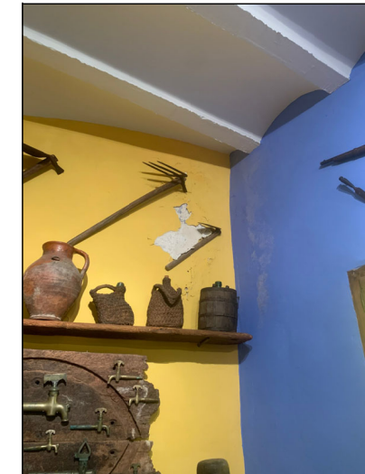
12. Repintat dels paraments verticals afectats per humitats
