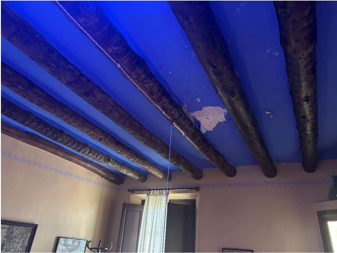
Sostre Sala 5 (planta primera)
