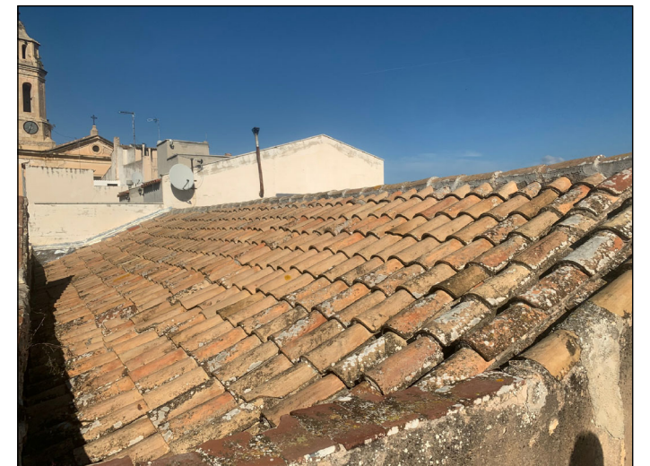
1. Substitució teules trencades
