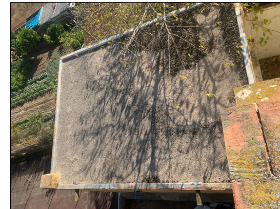
2. Aixecament coberta i formació nova coberta plana
