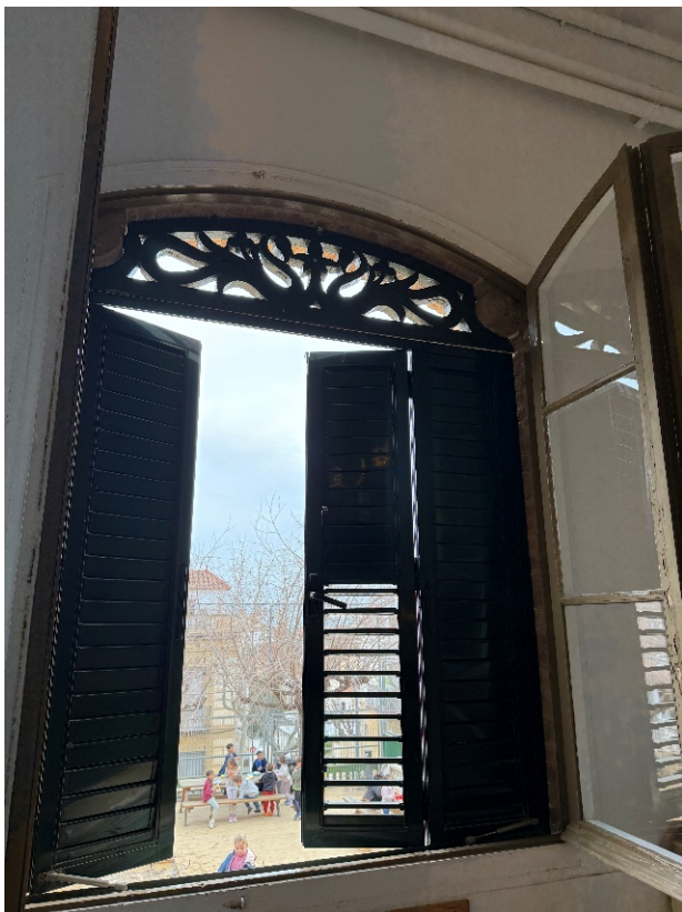
Elements protecció solar a retirar.
