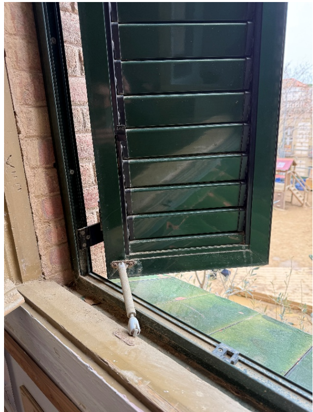
Elements protecció solar a retirar.
