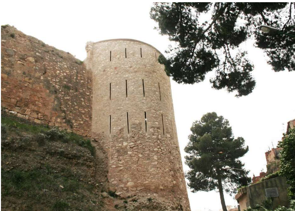
Imagen 9. Vista de detalle de la torre fusilera restaurada.
