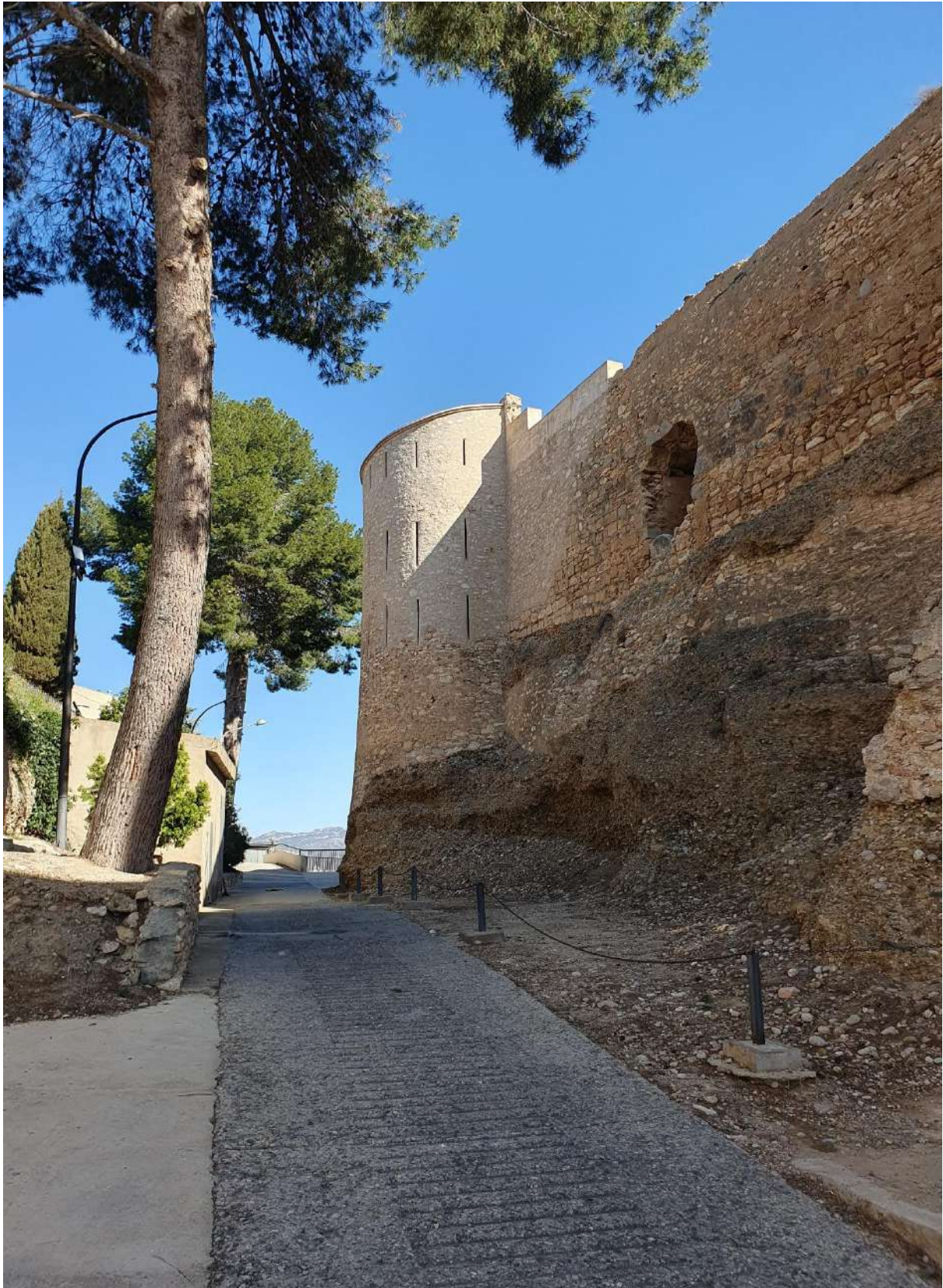
Imagen 7. Vista de la zona oeste con la torre fusilera desde la zona al acceso del castillo.
