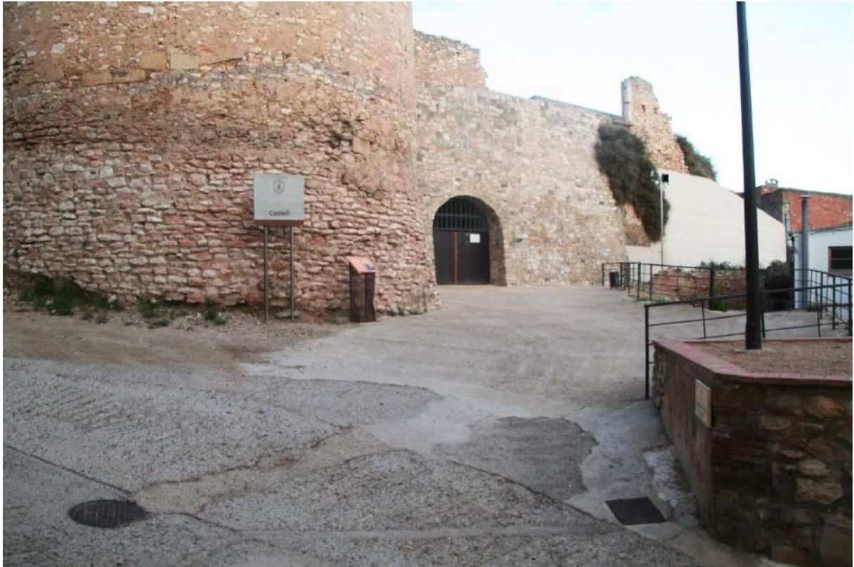
Imagen 10. Vista de la zona de acceso con la base de la torre circular y la puerta del castillo al fondo.
