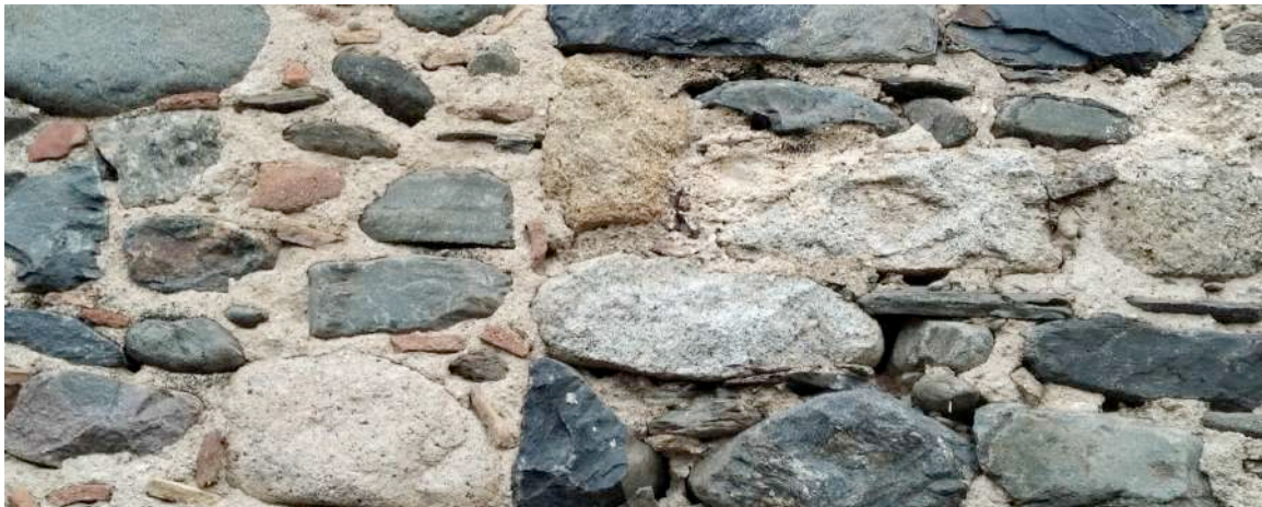
detall de la maçoneria de façana est
