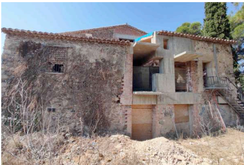
vista de la façana nord amb les terres acumulades a fase 1 en primer terme
