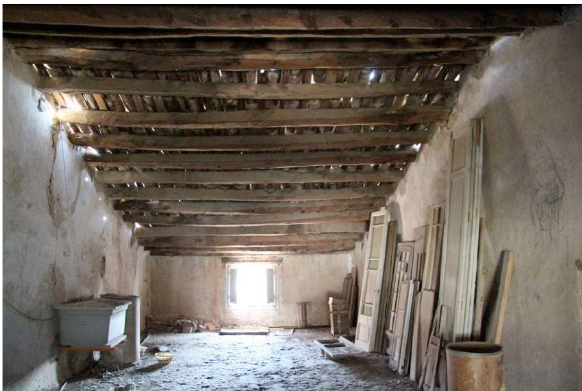
fotografia de la planta sotacoberta de la crugia central en el seu estat original
