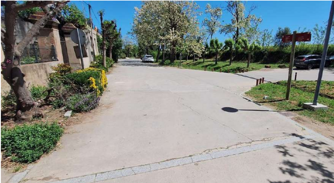
Fotografia 1_ Passeig de les Acàcies, vista cap a est, a l'inici de la zona d'actuació.
