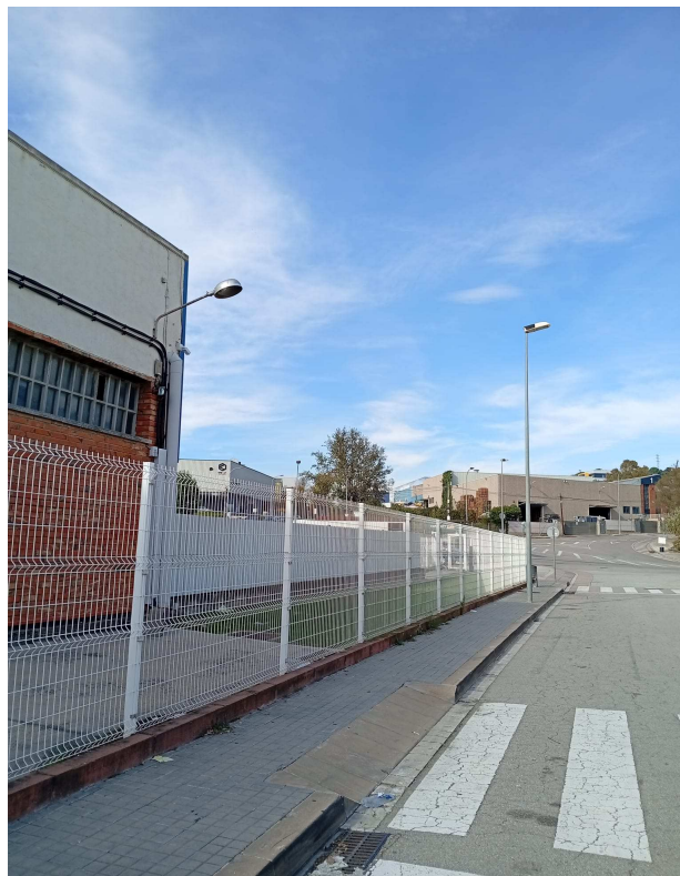
L·luminàries de vapor de sodi al carrer Miquel Servet
