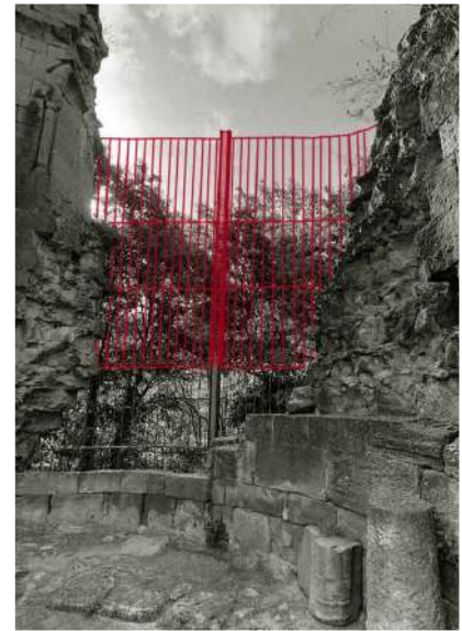
INTERVENCIÓ - Col·locació d'un tanca més alta que permeti protegir l'accés posterior, seguint l'estructura existent.
