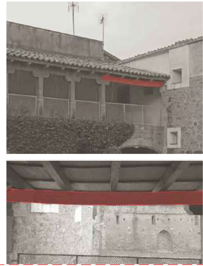
INTERVENCIÓ - Substitució de biga de fusta flexada amb perfil de col·lapse.
