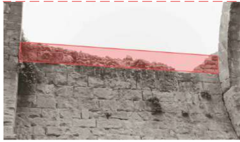
INTERVENCIÓ - Col·locació de pedres per reomplir zones amb desprendiments i evitar futures patologies i possibles desprendiments que puguin ocasionar perill pels usuaris
