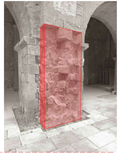
INTERVENCIÓ - Col·locació de pedres per reomplir zones per tal de millorar la estabilitat de la estructura existent.
