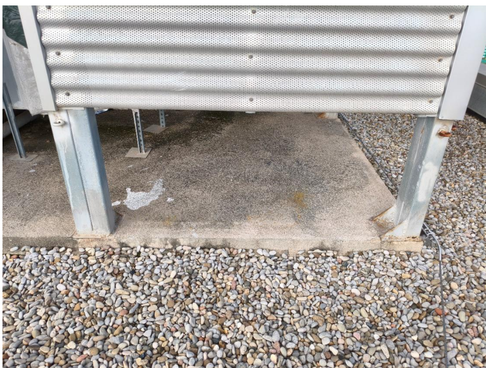
Foto 10: Llosa de formigó per a instal·lacions de coberta i detalls tancament
