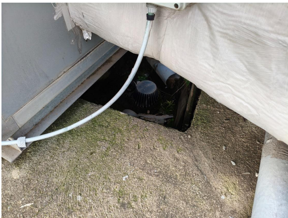
Foto 12: Desguàs existent sota llosa formigó
