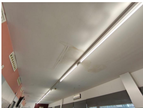
Imatge 10: Patologia sastre passadís de planta primera
