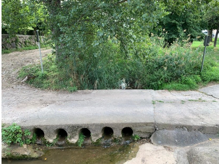
Eliminació de vegetació que envaeix la llera.
