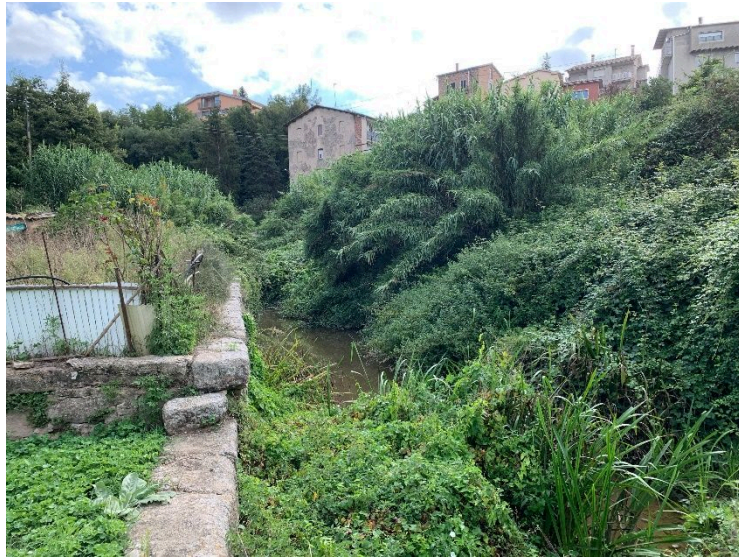
Desbrossament del mur d'endegament.
