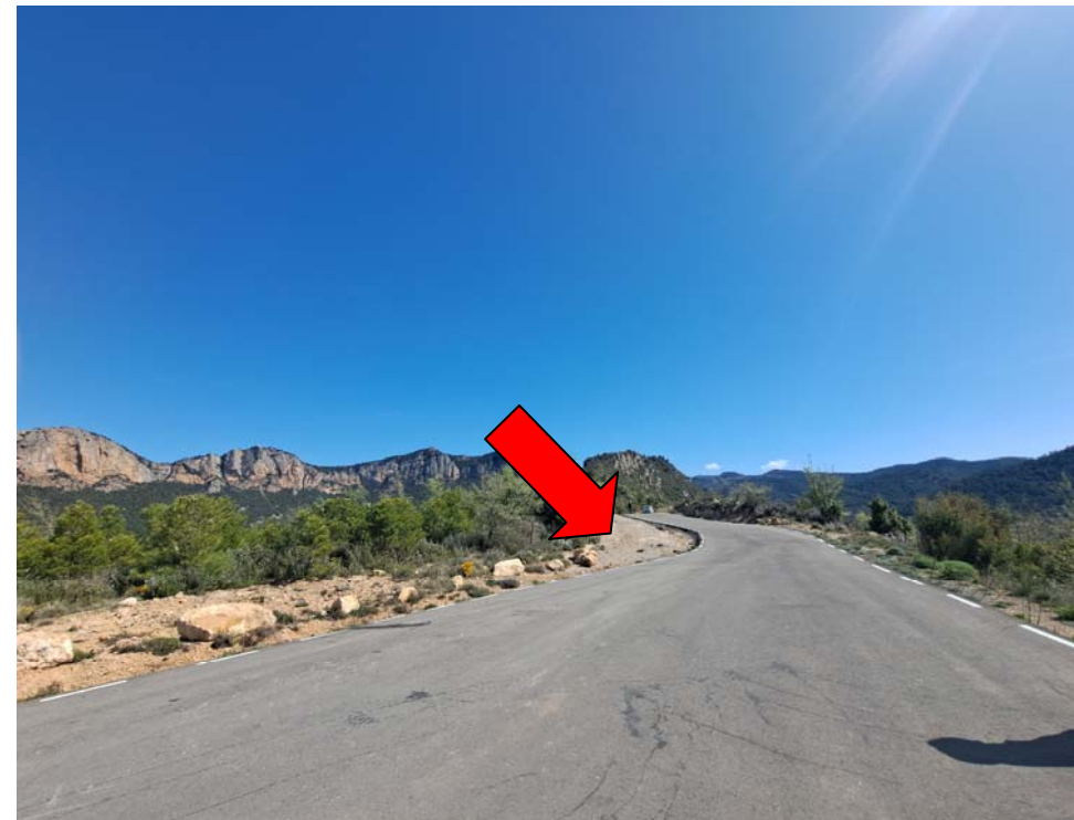
8 Camí de la Valldan. El nou tub d'abastament en alta de la nova xarxa passarà per la cuneta esquerra, és a dir, baixant, a la dreta
