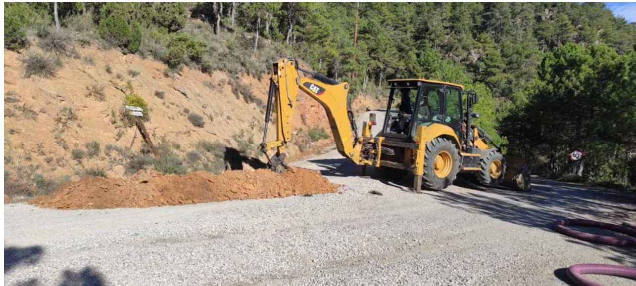
5 Tub soterrat al creuament de confluència del camí de Cal Marc al camí asfaltat de la Valldan (treballs previs asfaltat del camí Valldan)
