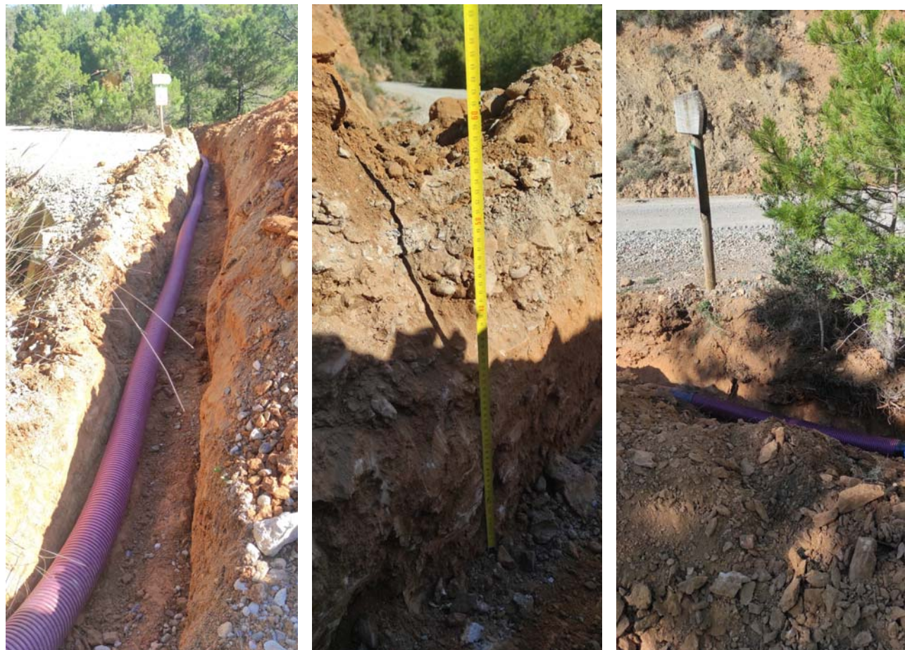
6 Tub soterrat al creuament de confluència del camí de Cal Marc al camí asfaltat de la Valldan (treballs previs asfaltat del camí Valldan)
