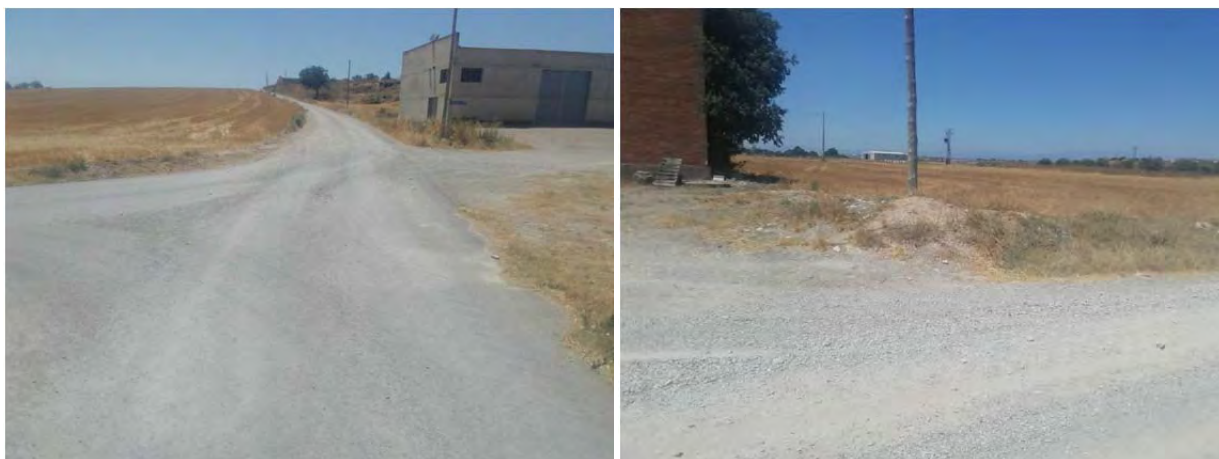
Imatges serveis existents en el camí d'Arbeca (TM Preixana)
