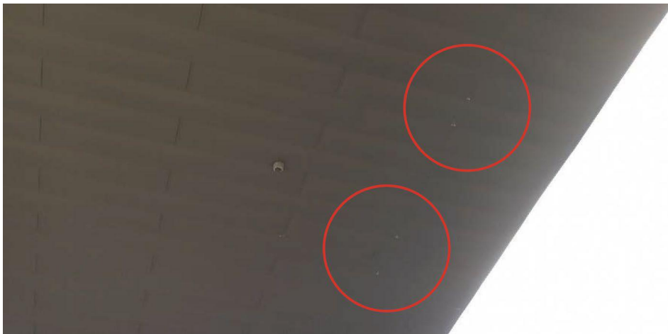
Detall taques en voladís de plaça de les Glòries
