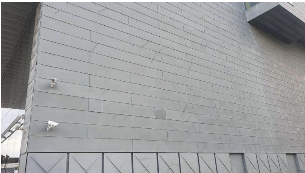
Detall de la façana lateral cap a la Plaça Santiago Pey
