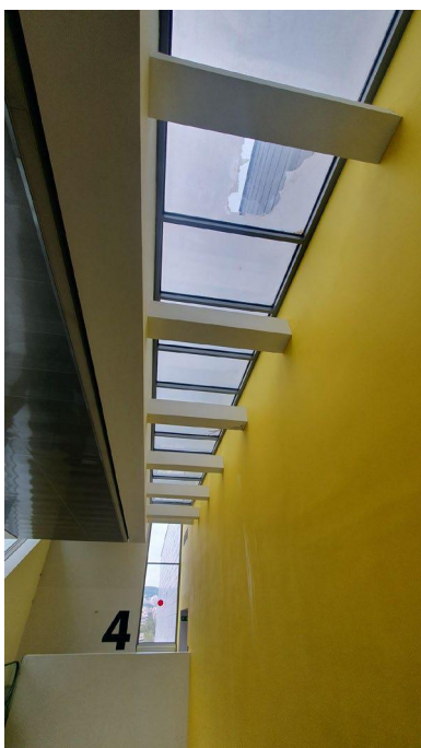
Vista de la lluerna per l'interior
