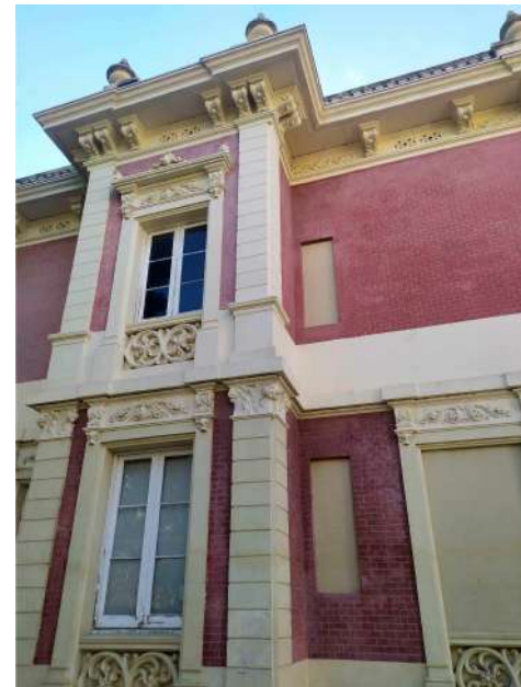
FOTOGRAFIA 07 BALCONERA FAÇANA LATERAL NORD-OEST
