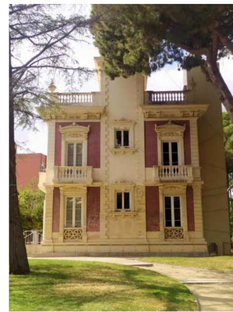
FOTOGRAFIA 04 FAÇANA LATERAL SUD-EST
