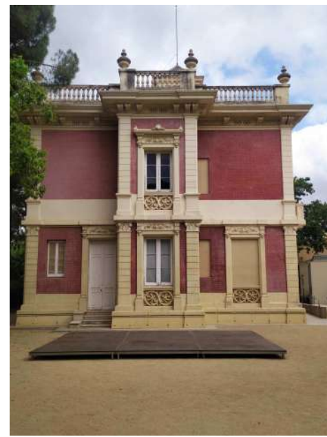
FOTOGRAFIA 03 FAÇANA LATERAL NORD-OEST
