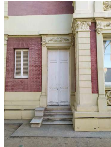
FOTOGRAFIA 08 ACCÉS POSTERIOR EN FAÇANA LATERAL NORD-OEST
