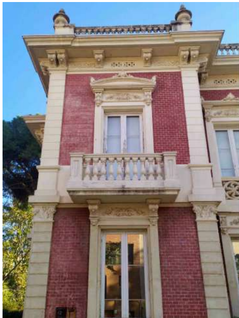
FOTOGRAFIA 05 BALCONERA FAÇANA PRINCIPAL SUD-OEST
