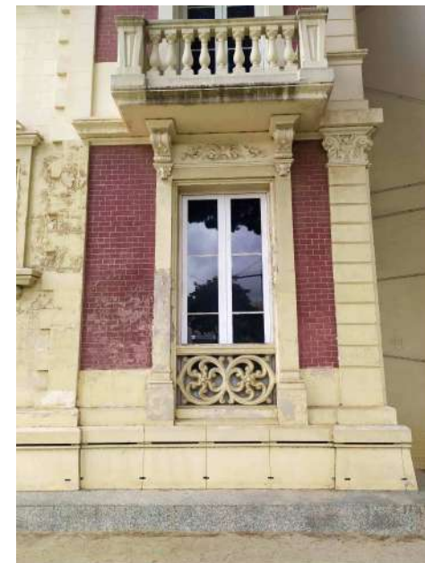
FOTOGRAFIA 12 BALCONERA FAÇANA LATERAL SUD-EST
