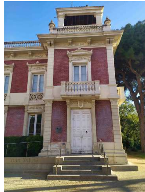
FOTOGRAFIA 06 ACCÉS EN FAÇANA PRINCIPAL SUD-OEST
