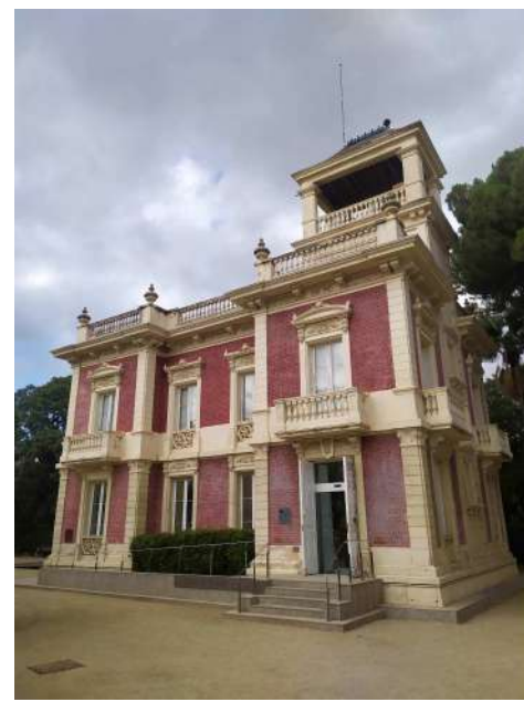
FOTOGRAFIA 02 FAÇANA PRINCIPAL SUD-OEST AL C. DE L'ESGLÉSIA
