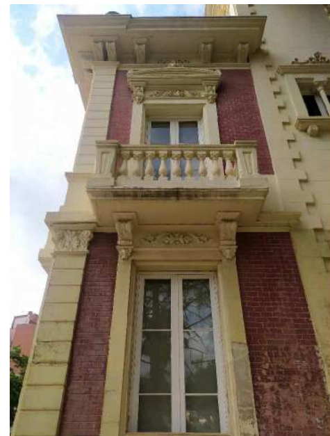
FOTOGRAFIA 11 BALCÓ FAÇANA LATERAL SUD-EST
