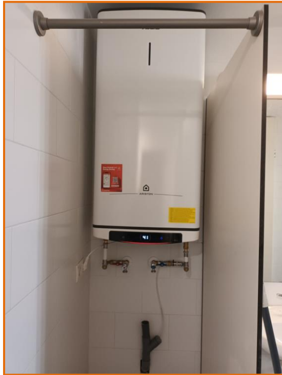
Figura 21: Fotografia del detall de la conducció de la vàlvula de seguretat de l'escalfador elèctric al desaigua de la rentadora
