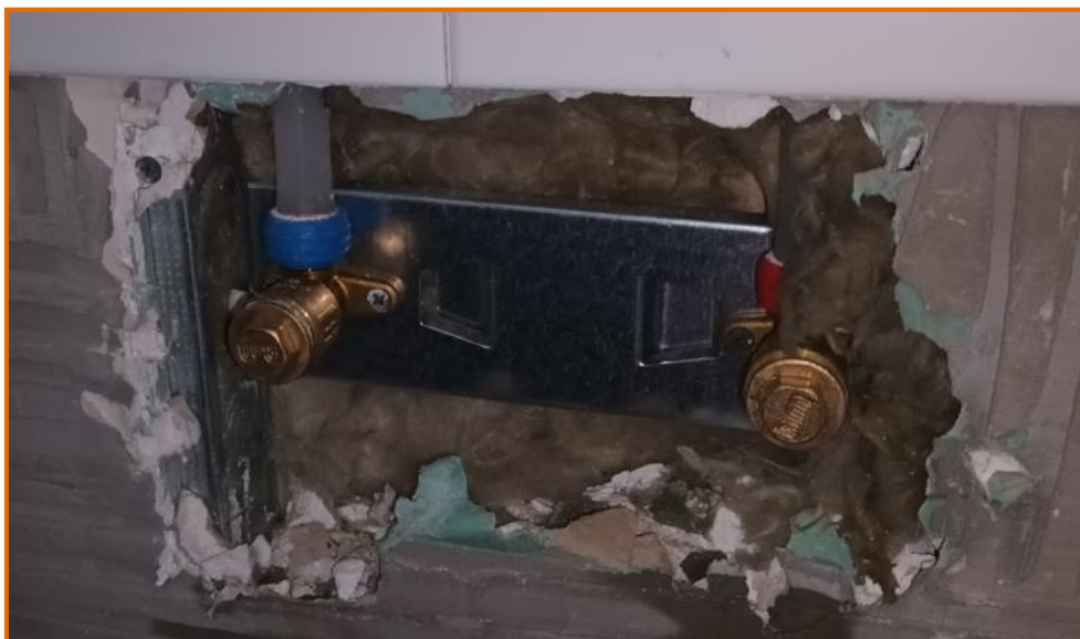
Figura 20: Fotografia de la peça de fixació canviada amb els colzes de llautó
