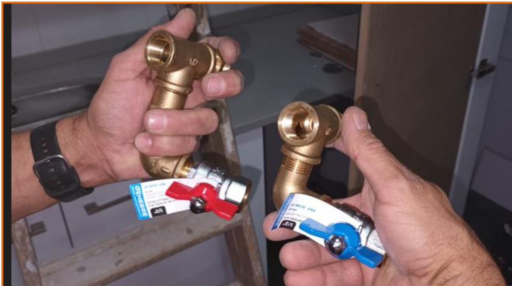
Figura 21: Fotografia de les T i vàlvules de tall
