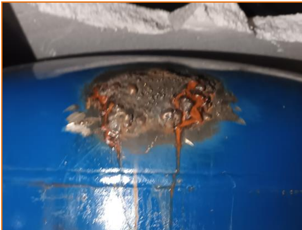
Figura 7: Fotografia de la reparació realitzada en el dipòsit.
