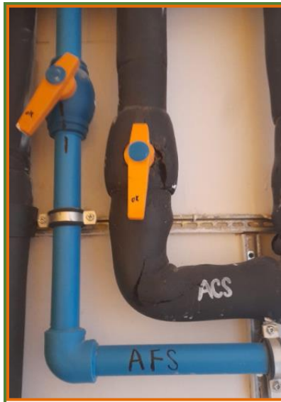
Figura 22: Fotografia de les vàlvules de bola del habitatge
