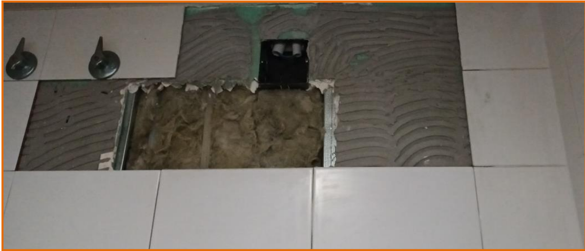
Figura 17: Fotografia d'identificació dels muntants del pladur
