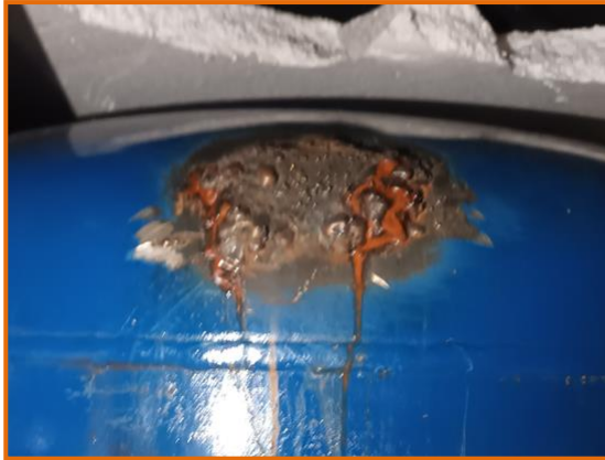
Figura 8: Fotografia de la reparació realitzada – agost de 2024.
