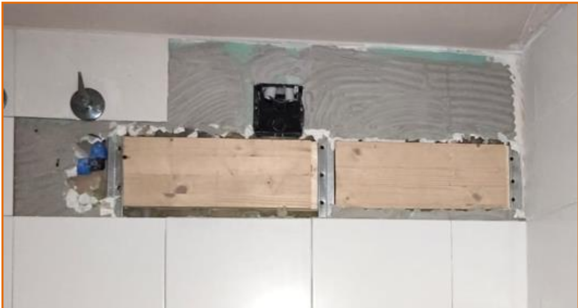
Figura 18: Fotografia de reforç estructural entre muntants amb tacs de fusta
