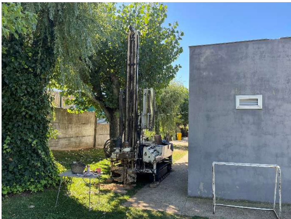
Fotografia 1. Emplaçament del sondeig S-1.
