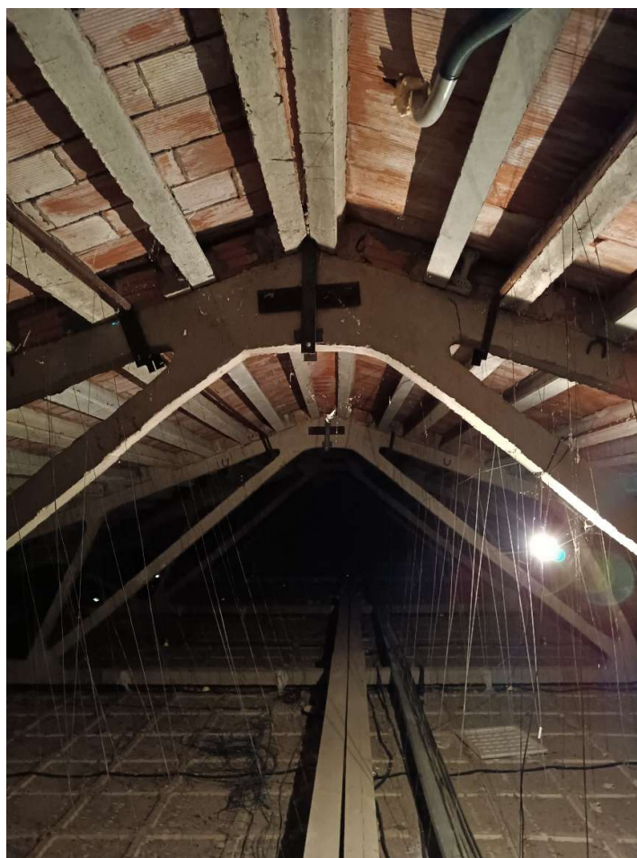
Fig. 3 Vista estructura de la coberta
