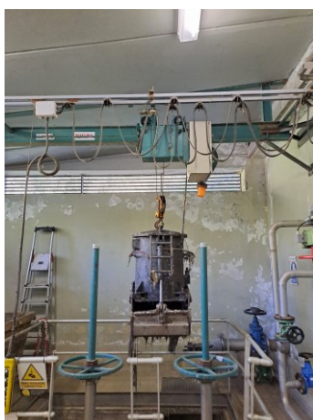
Diferents vistes de les culleres bivalva actuals: EDAR d'Olot (línia superior), EDAR Santa Pau (centre) i Llierca (inferior).
