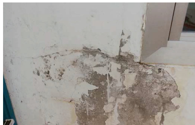
In 29: Exemple d'esquerda vinculada a una finestra
