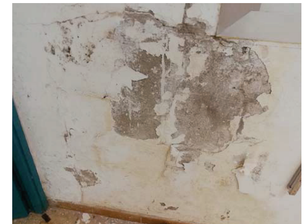
In 17: Detall de la taca d'humitat.
