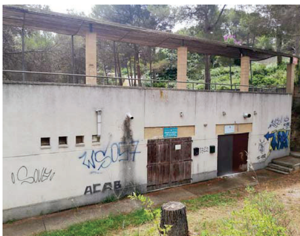
In 4: Vista de la façana Oest
