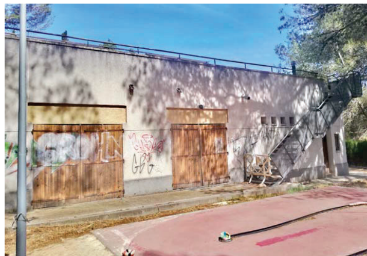
In 3: Façana Est de l'edifici, on esta l'escala al pis superior.
