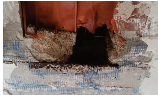
In 10: Detall de cala realitzada. A l'interior es pot veure l'armat de la capa de compressió.
