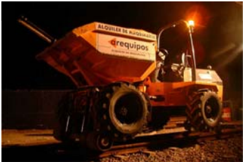
DUMPER HABILITAT PER A CIRCULAR SOBRE CARRIL
