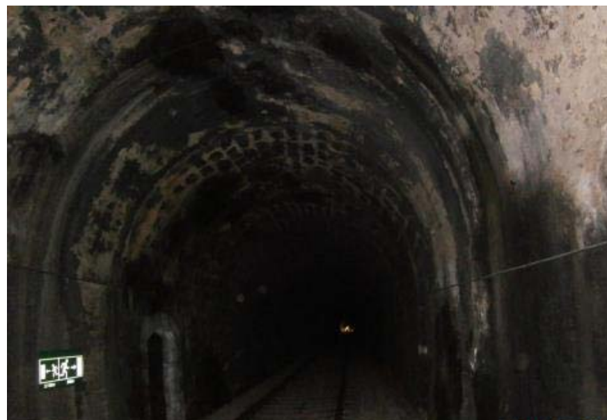
Vista d'un tram del túnel
