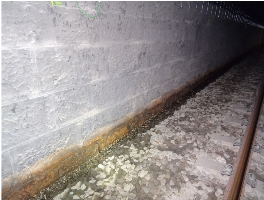
Figura 5. Imatge de la circulació d'aigua a la cuneta.
