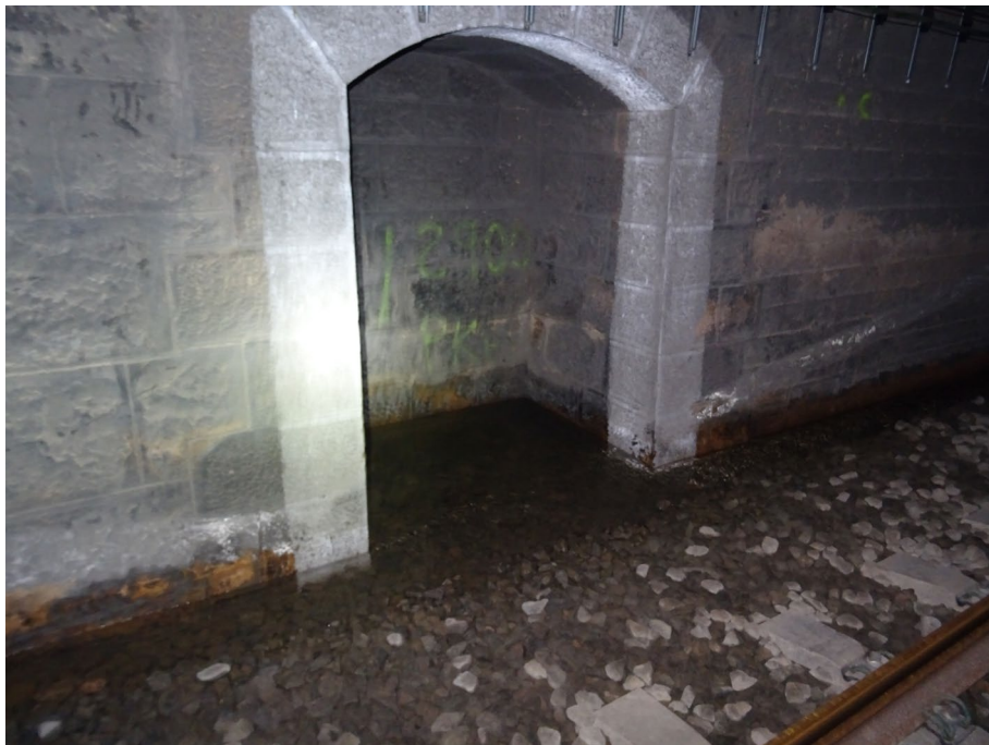
Figura 6. Imatge de la circulació d'aigua a la cuneta.
