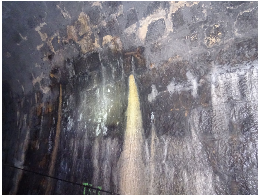
Figura 4. Vista de les surgències d'aigua a pressió que s'han observat.
