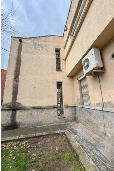
Ubicació de l'elevador a l'exterior
