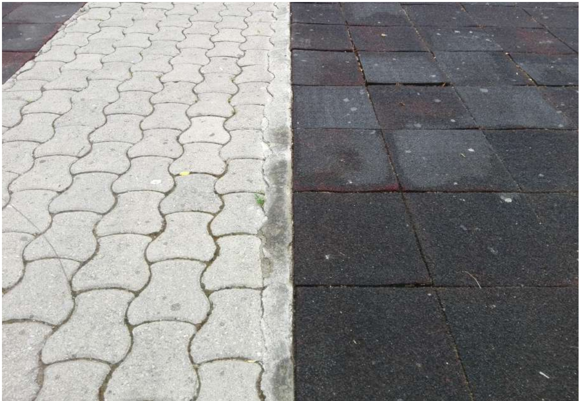
Fotografia 11. Pavimenta del parc. Lloseta de formigó i lloseta de cautxú
