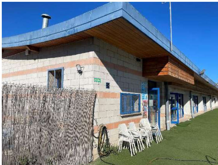
Connexió a impulsió existent per la deshumectadora 2
