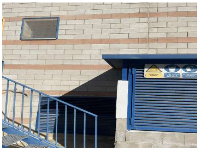
Entrada del retorn per la deshumectadora 2 i recorregut del conducte de retorn
