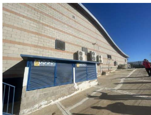
Entrada del retorn per la deshumectadora 2 i recorregut del conducte de retorn
