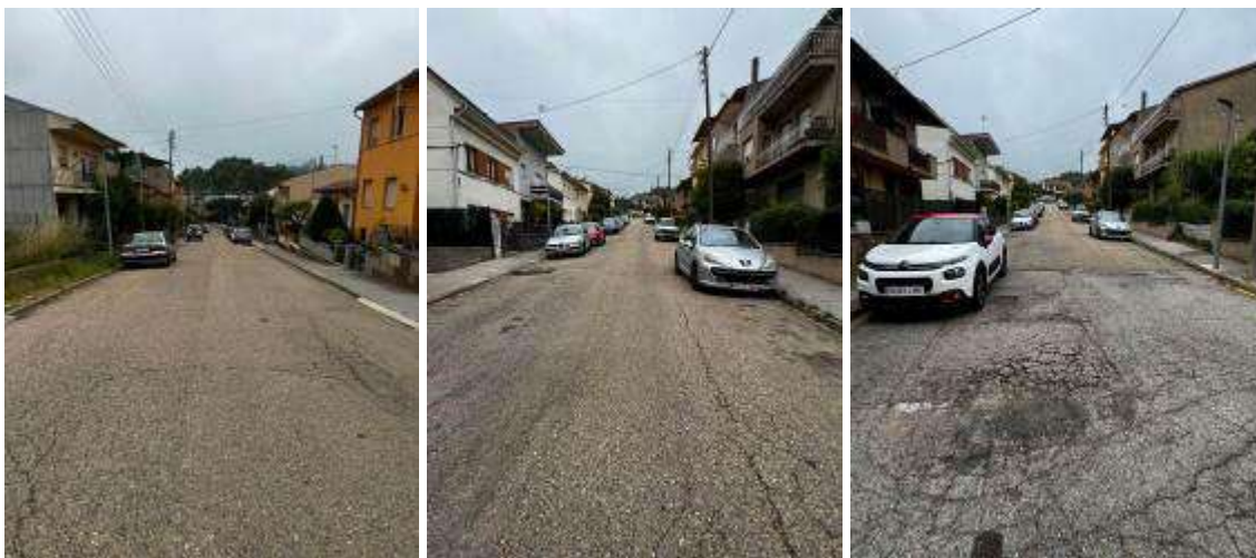
Imatges diverses del ferm malmès en el C. Álvarez de Castro.
