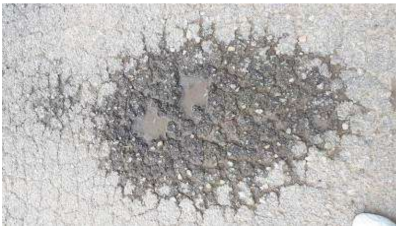
Asfalt quartejat en què la presència d'aigua, sal i gel n'acceleren la seva descomposició
