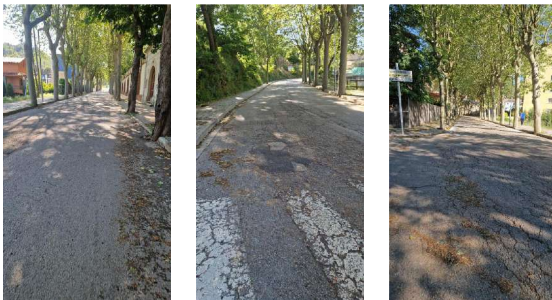
Imatges diverses del ferm malmès del Passeig de la Font del Cirerer.
