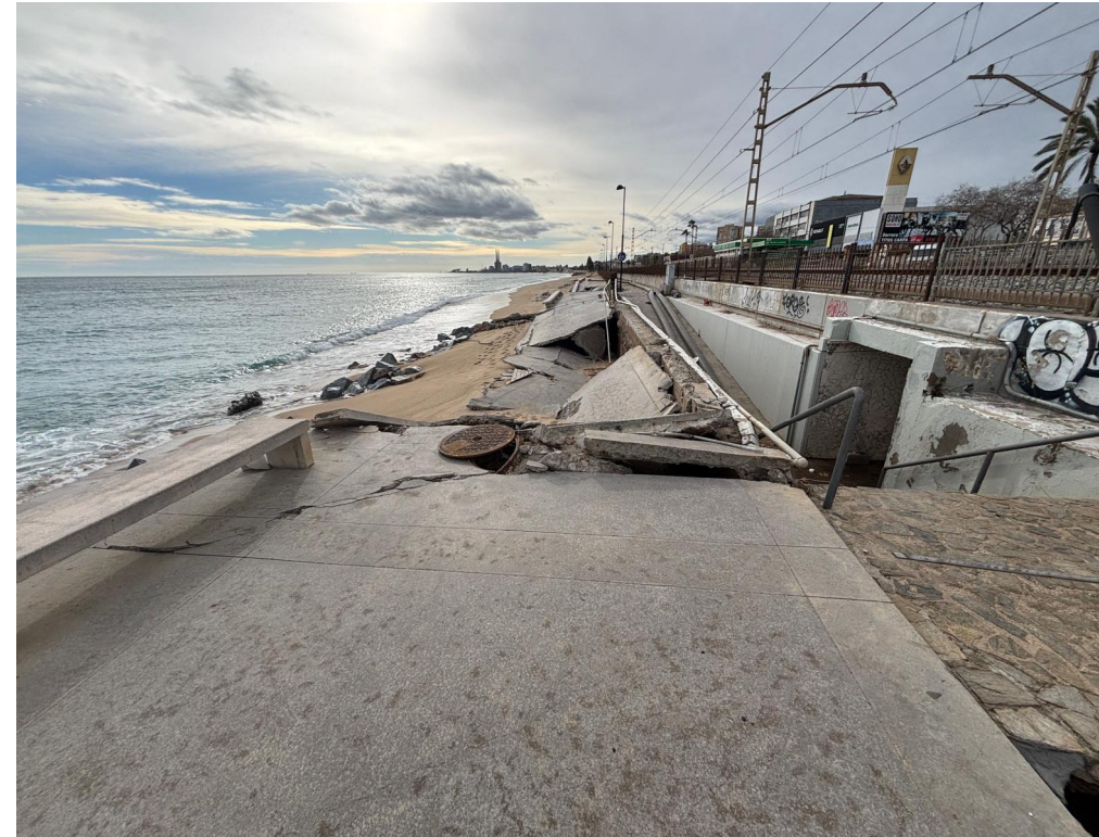
Imatge 1.- Vista del tram on es va produir la ruptura global del vial
