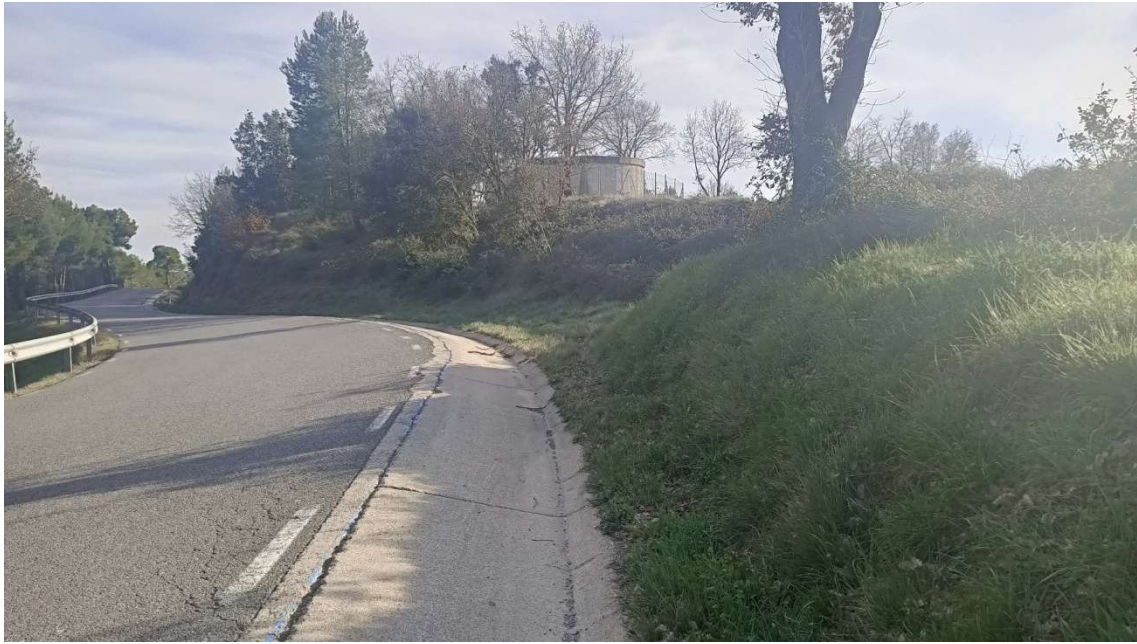
Accés dipòsit de la Guardiola
