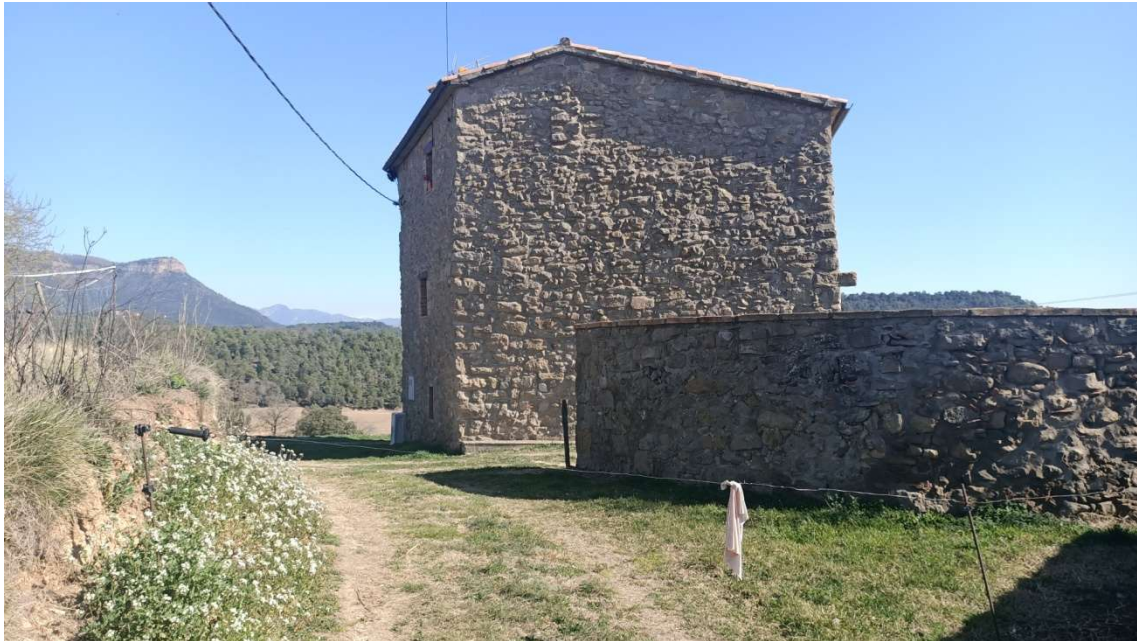
Ramal La Caseta
