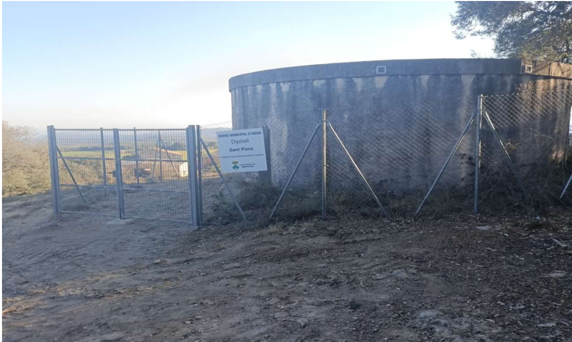
Dipòsit de Sant Pons (amb canalització FO existent)
