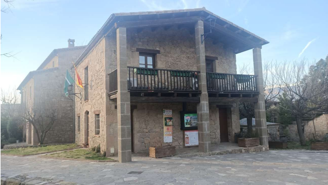
Ajuntament de Montclar (amb canalització FO existent)
