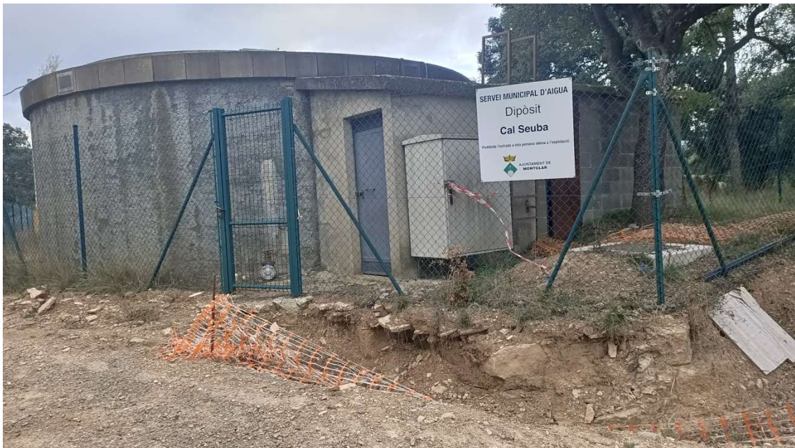
Dipòsit de cal Seuba
