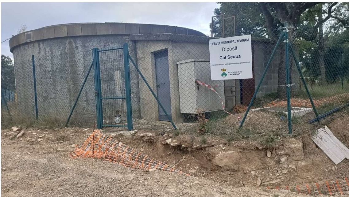
Dipòsit de Cal Seuba
