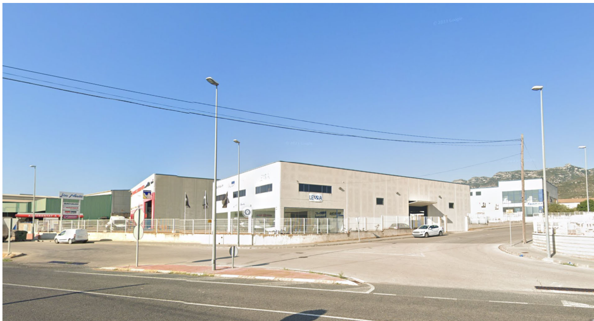
Vista general de la cruïlla del polígon amb la carretera nacional
