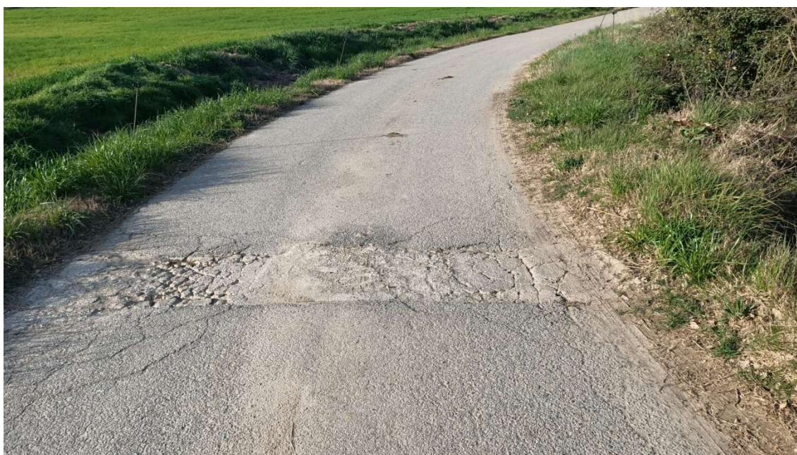
Tram 2 Obra de drenatge amb tub de polietilè corrugat doble paret de D400 mm
