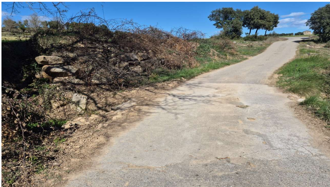
Tram 3 Obra de drenatge amb tub de formigó de D600 mm
