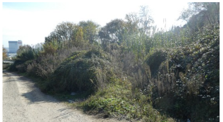
16. Torrent de la Nogueta, tram 1
