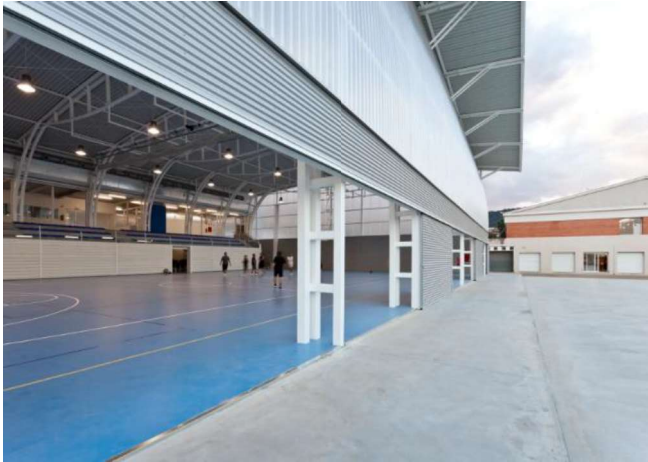
Fotografia interior – pav.inical capa inferior de l'actual
