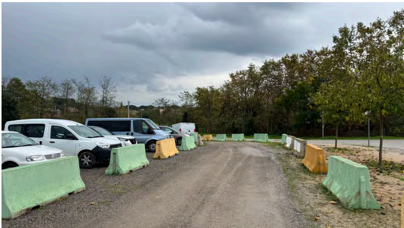
El paviment de la zona de vehicles està format per una barreja de materials granulars reciclats tipus formigó i fressat d'asfalt. La zona de circulació dels vehicles s'ordena mitjançant barreres prefabricades de formigó tipus New Jersey.
