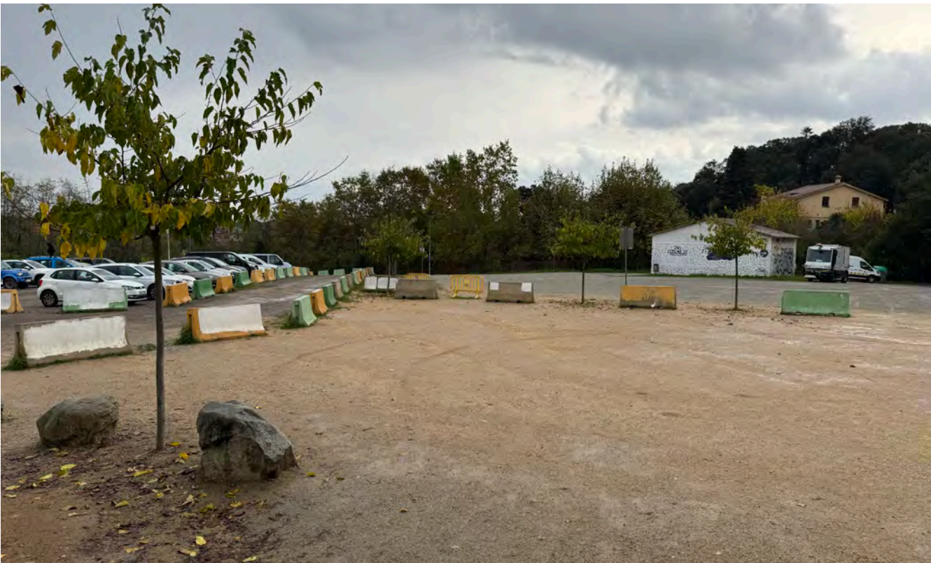
En primer terme es pot observar que la zona propera a l'accés està formada per una capa de sauló.
