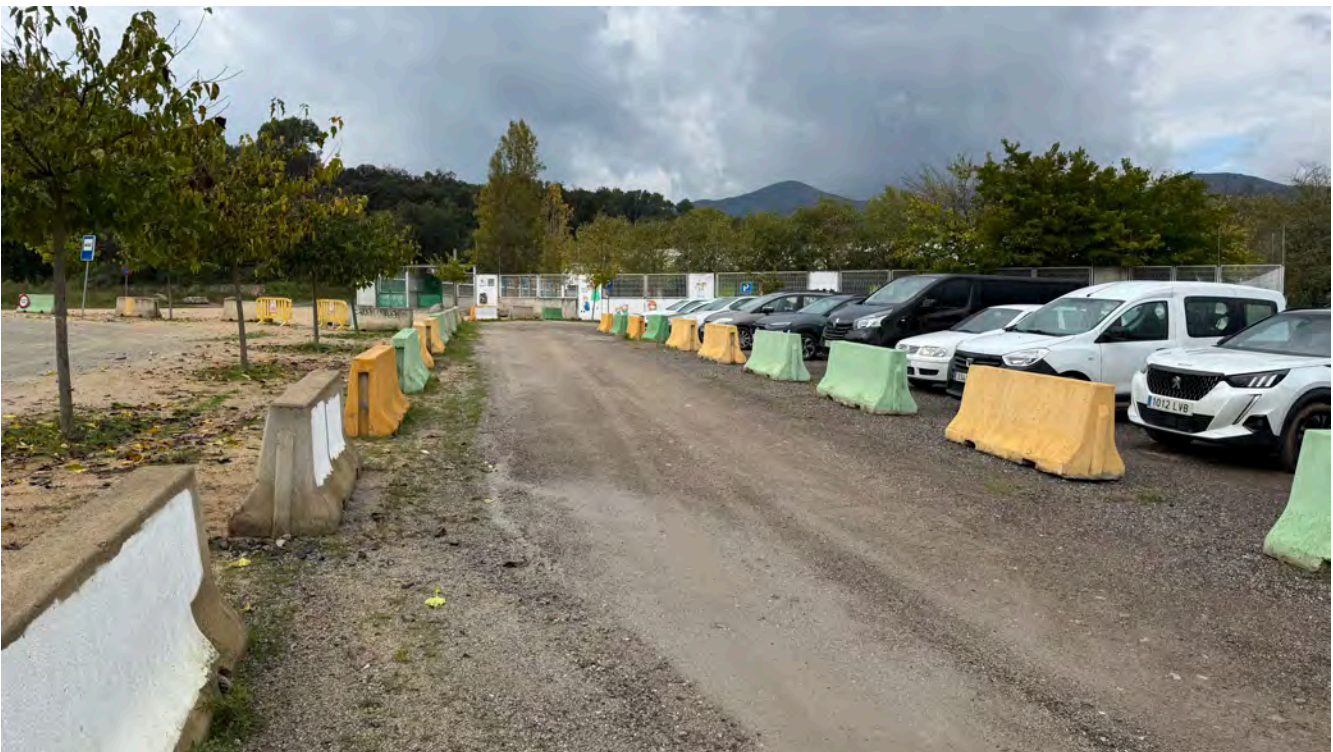
Perspectiva inversa, és a dir en sentit contrari al de la marxa dels vehicles que voregen la zona d'aparcament. El paviment de la zona de circulació és del mateix tipus que el de la zona d'aparcament de vehicles. Està format per materials granulars reciclats tipus formigó i fressat d'asfalt que amb el pas del temps s'ha acabat barrejant amb la terra del terreny existent.
