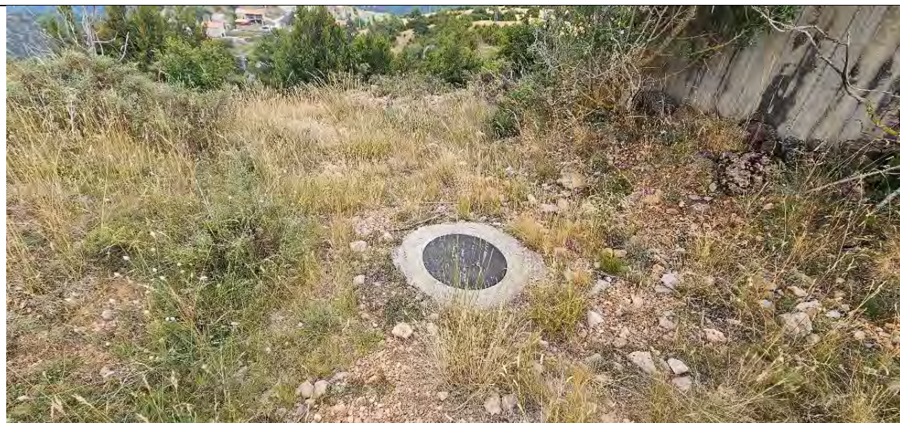
Foto 6.- Fi traçat. Arqueta connexió dipòsit
