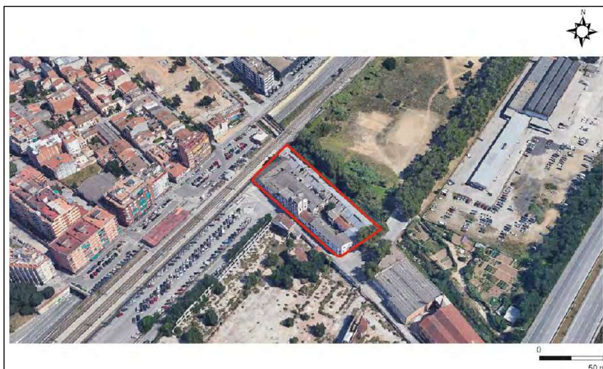
Ilustración 1. Situación del emplazamiento antes de su demolición. En rojo parcela catastral
