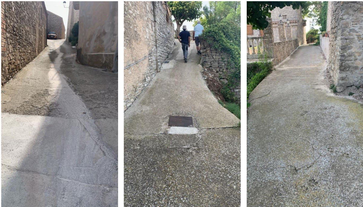
Carrers estrets on s'hauran d'utilitzar mitjans manuals per a realitzar l'excavació de la rasa.
