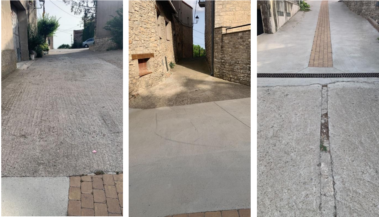
Carrers amb paviment de formigó amb diferents acabats.
