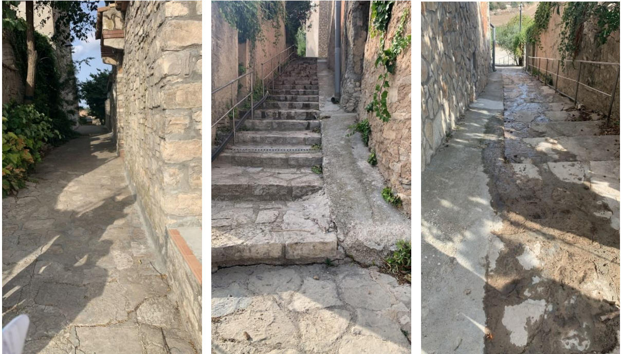
Zones amb escales on s'haurà d'utilitzar mitjans manuals per a realitzar l'excavació de la rasa.
