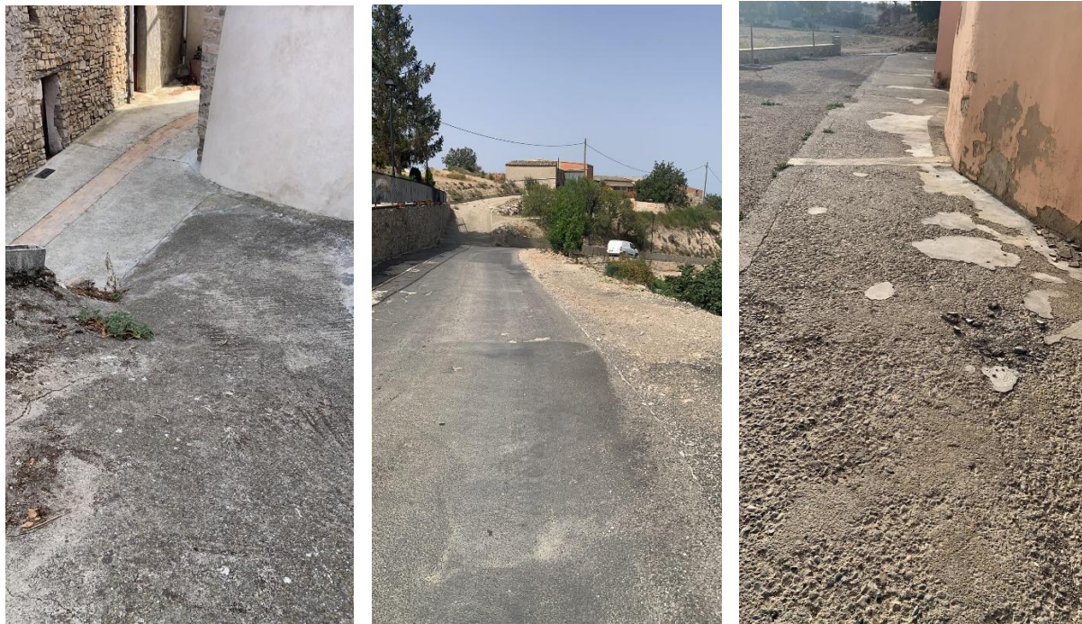
Carrers amb paviment de formigó pels que transcorre la canonada d'aigua potable a substituir al municipi de Talavera.
