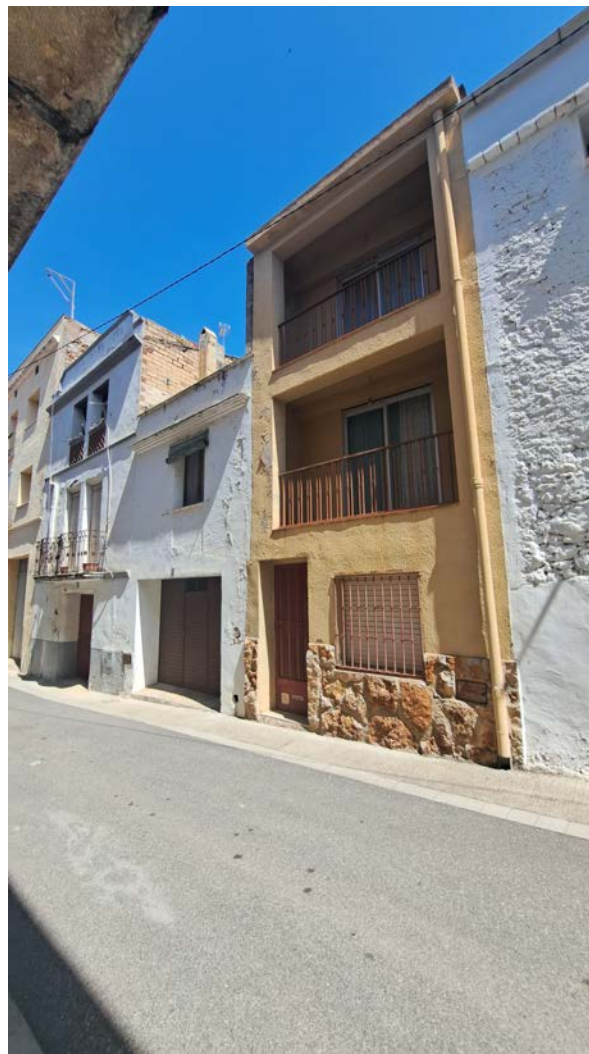
Imatge de la façana accés Carrer Unió nº9
