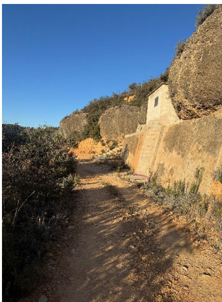
4. Final camí a formigonar.
