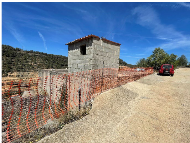
1. Caseta sobre dipòsit
