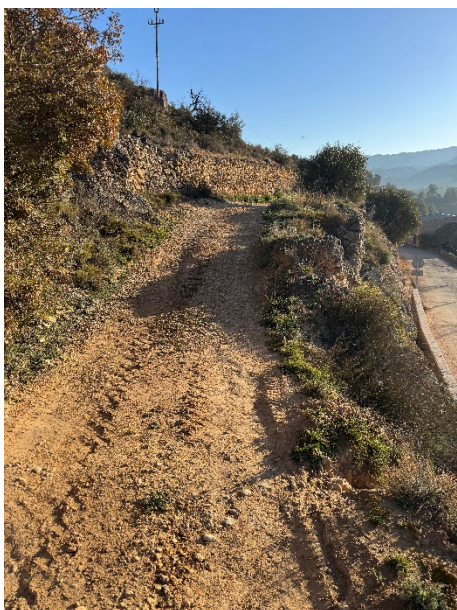
3. Inici camí a formigonar.
