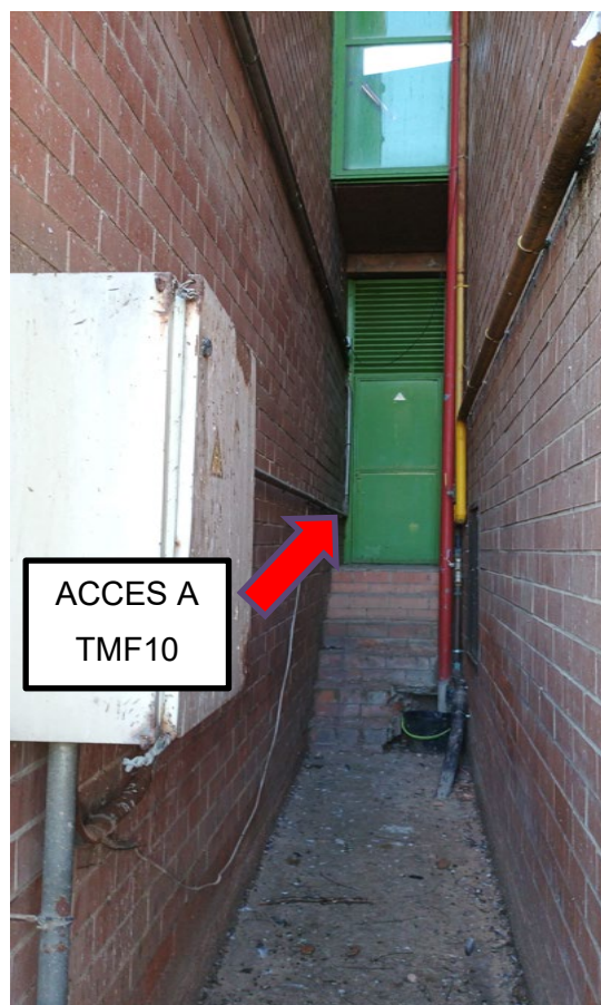
Imatge 6: Accés a sala Escomesa elèctrica existent TMF10
