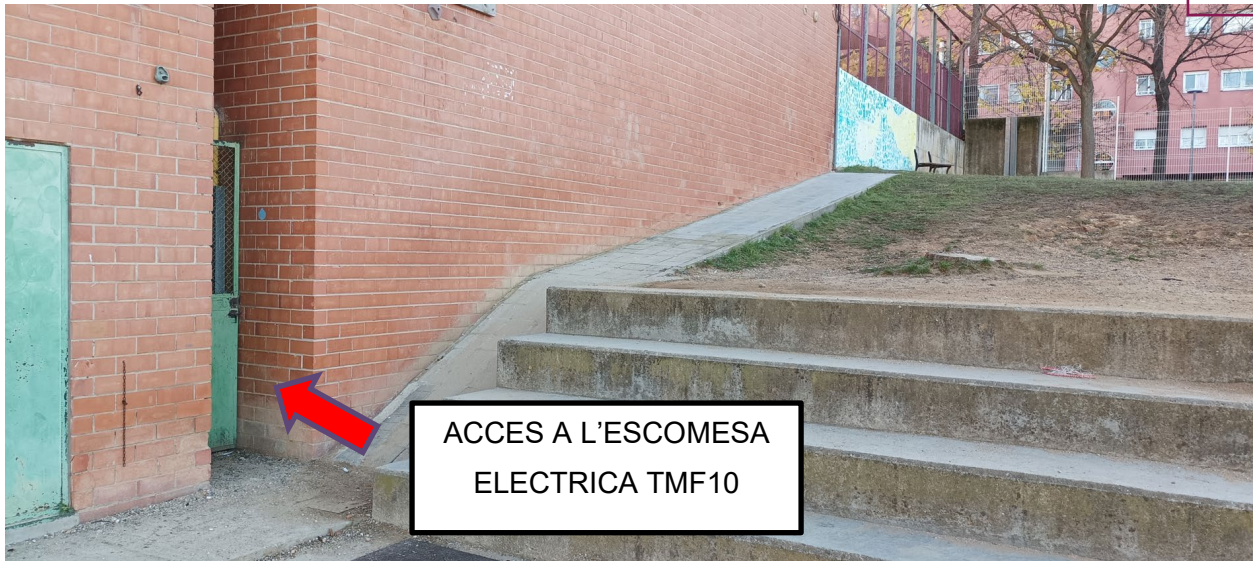
Imatge 5: Recorregut cablejat elèctric entubat per façana des de quadre elèctric general fins subquadre sala grup bombeig PCI
