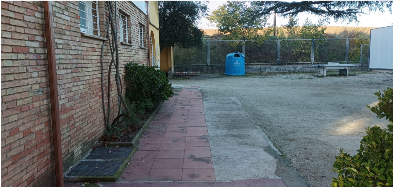
Imatge 5: Ubicació caseta d'obra de grup pressió/dipòsits d'aigua i canalització nova instal·lació d'aigua contra incendis
