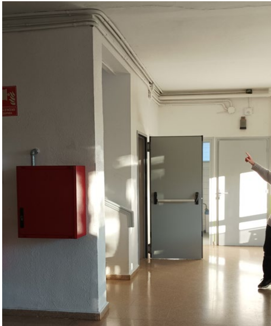
Imatge 10: Primer BIE connectat en planta baixa
