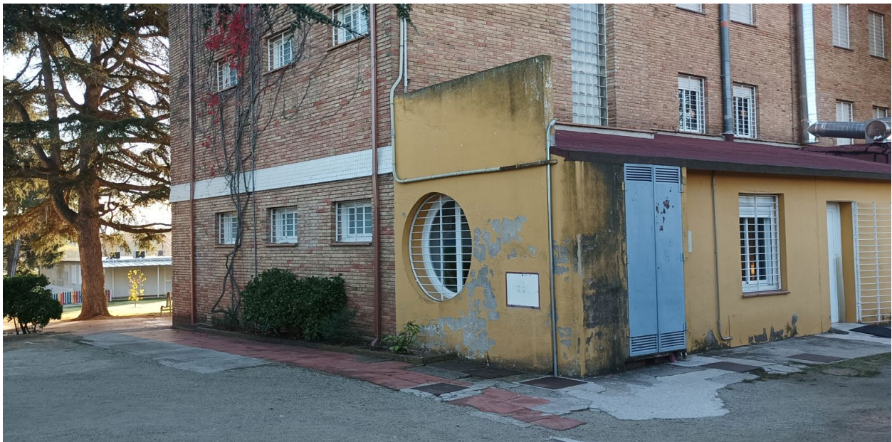
Imatge 6: Canalització nova instal·lació d'aigua contra incendis i entrada a l'edifici per lavabos / Escomesa elèctrica existent
