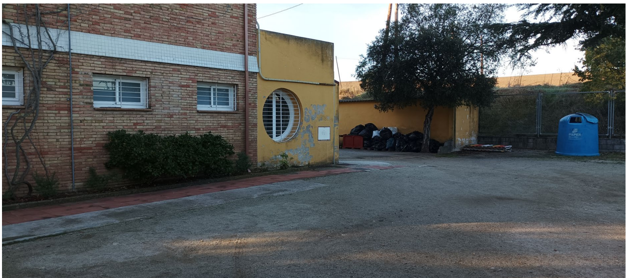
Imatge 4: Ubicació caseta d'obra de grup pressió/dipòsits d'aigua i canalització nova instal·lació d'aigua contra incendis
