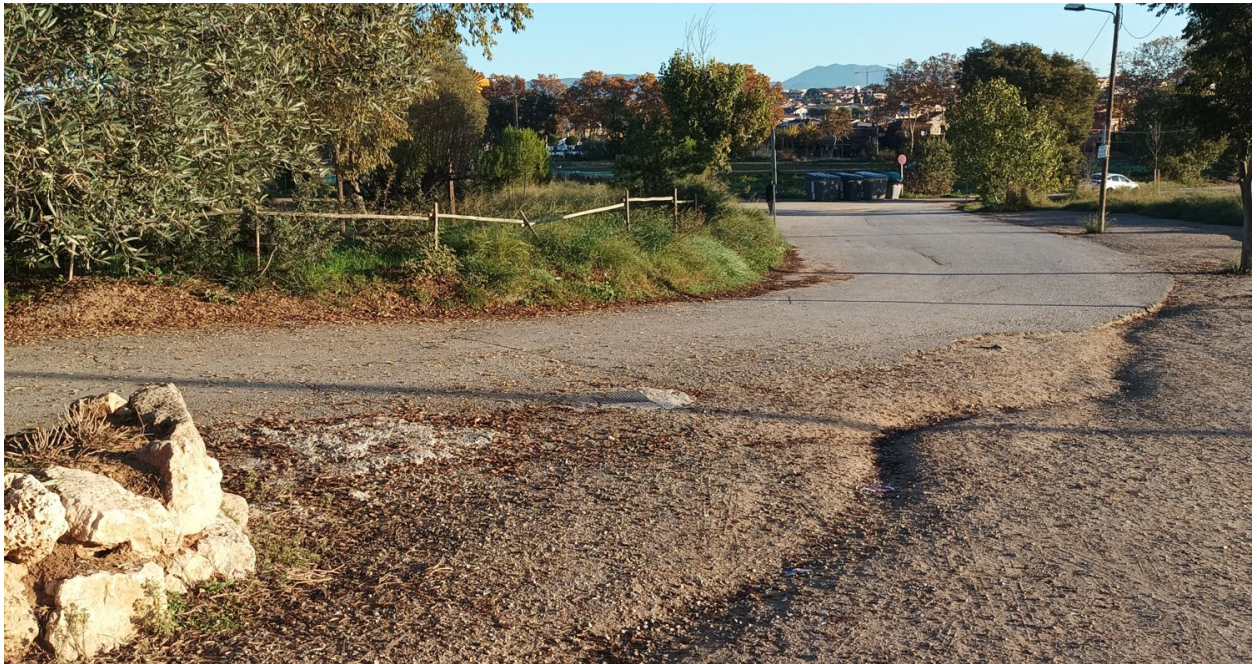
Imatge 1: Perico registrable entrada aigua a l'edifici
