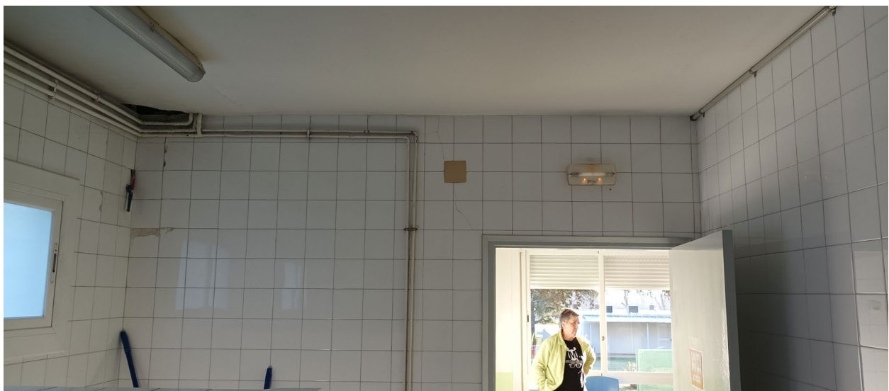
Imatge 11: Nova instal·lació tubera d'aigua PCI des de l'exterior per lavabo
