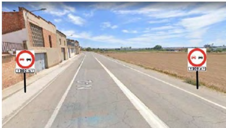
Senyalització vertical en inici del separador de fluxos.
