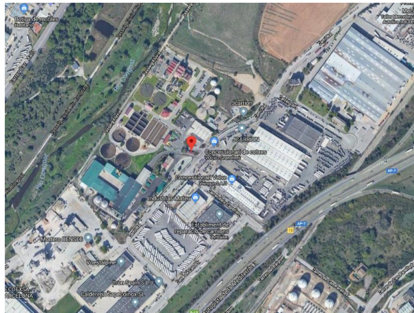
Figura 1. Vista aèria del CCTRVO. Font: Google Maps 2019.
