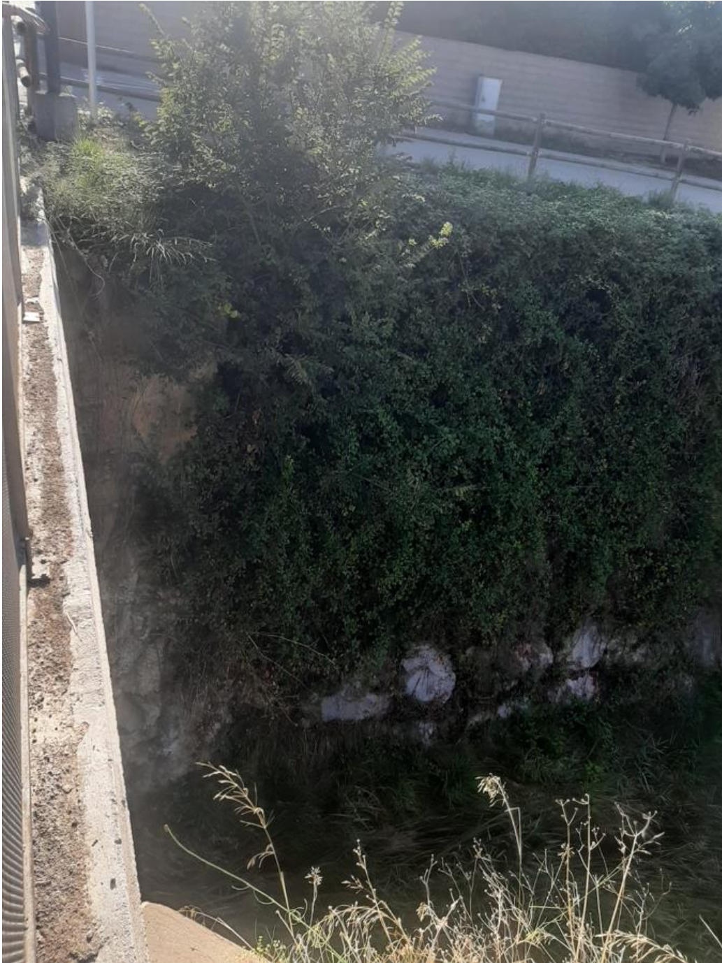
Marges a desbrossar
