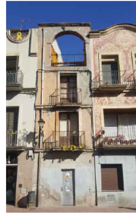
Façana Plaça de la Vila, 23
