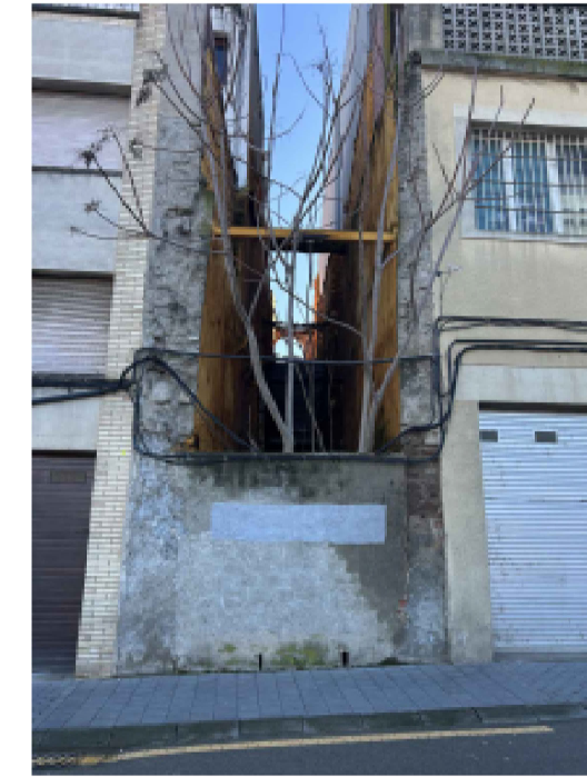
Façana Carrer del Revall
