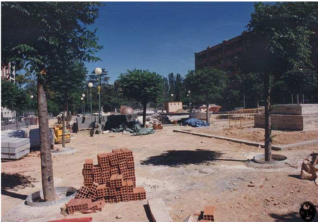
Fotografies de les obres d'urbanització (any 1998):
