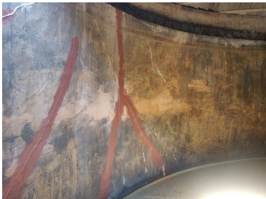
Il·lustració 5. Vistes interior del dipòsit, correspon a la darrer cop que es va realitzar una reparació d'esquerdes.
