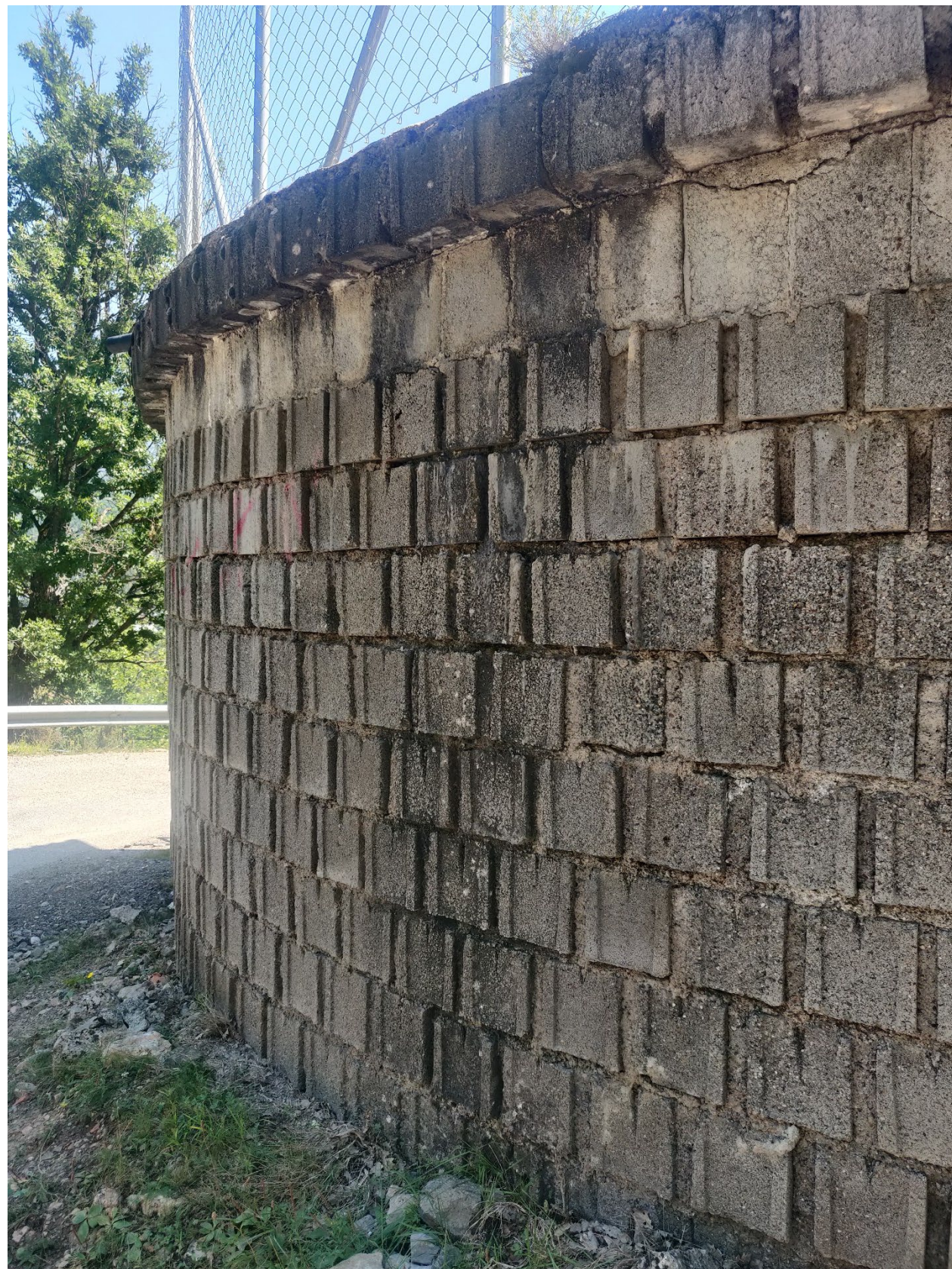
Il·lustració 3. Foto de l'estat de l'envolupant, amb nombroses esquerdes verticals
